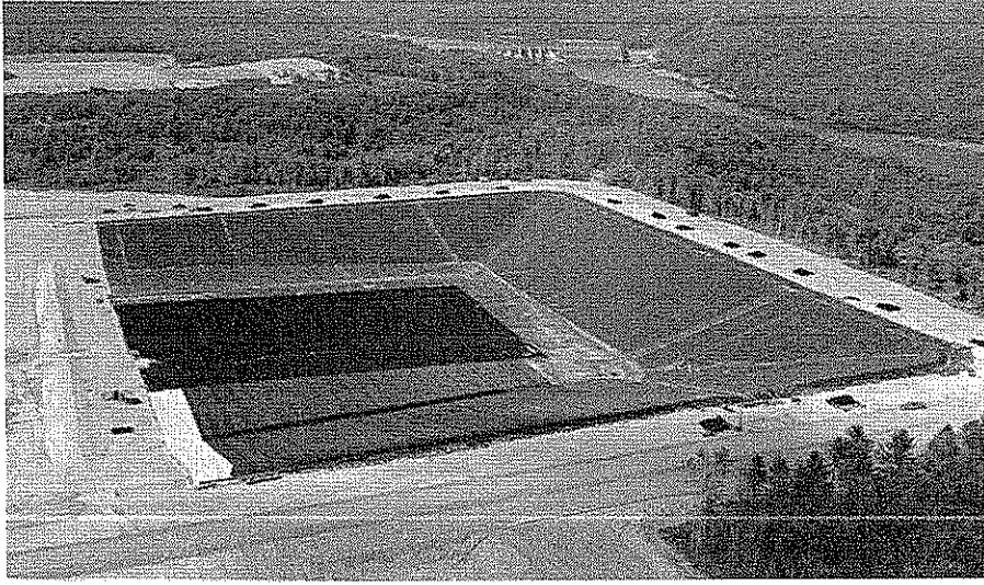
Şekil 1.9. İzmit’te yapılan bir çöplük arıtma tesisinin yalıtımı ( https://www.sanalsantiye.com/geomembran-nedir-nerelerde-kullanilir/ )
