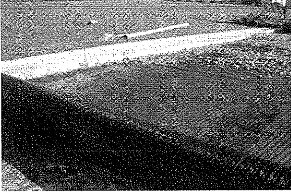
Şekil 2.3. Yollarda geogrid kullanımı (Ay, 2014)
