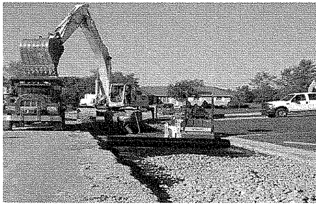
Şekil 2.2. Yollarda geogrid kullanımı (Ay, 2014)
