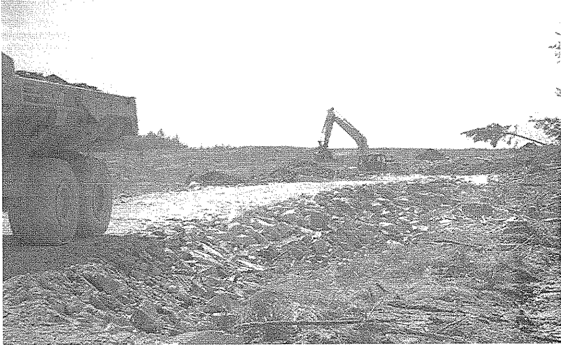
Resim 4.6 Kaplamasız yollarda geogrid kullanımı Kaynak: Tensar,2017
