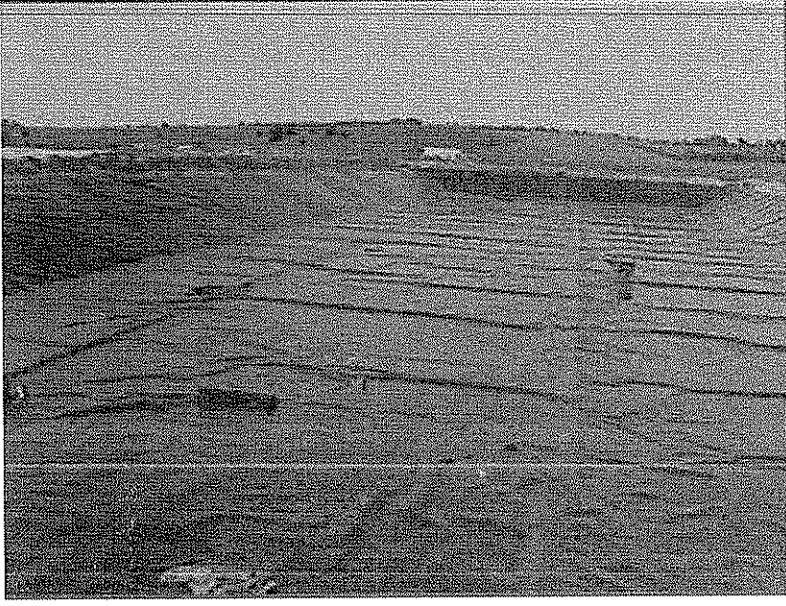
Resim 1.9. Geomembran uygulaması
