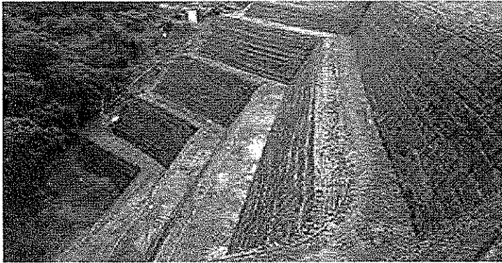
Resim 3.9.Şevlerde geogrid kullanım
