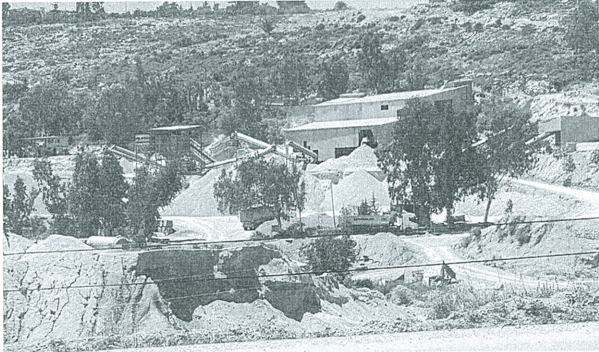
Şekil 3.7. 3nolu ocak (Kumkuyu Taş Ocağı) görünümü
