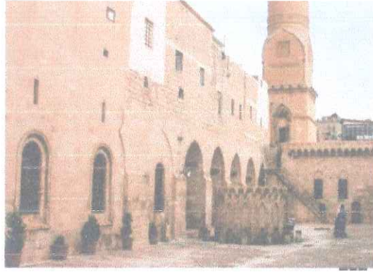
Şekil 30. Ulu cami Güney Cephesi
