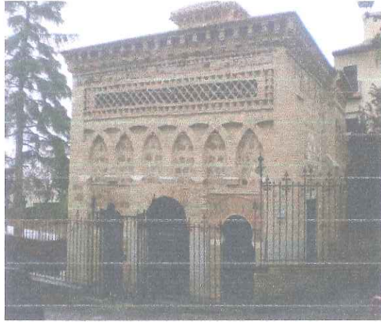
Şekil 43. Bab El-Mardum Camini Güneydoğu Cephesi
