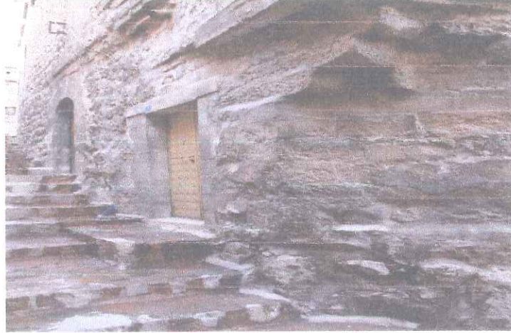
Şekil 11. Nezir NOYAN Evi Batı Cephesi Birinci Giriş Kotu
