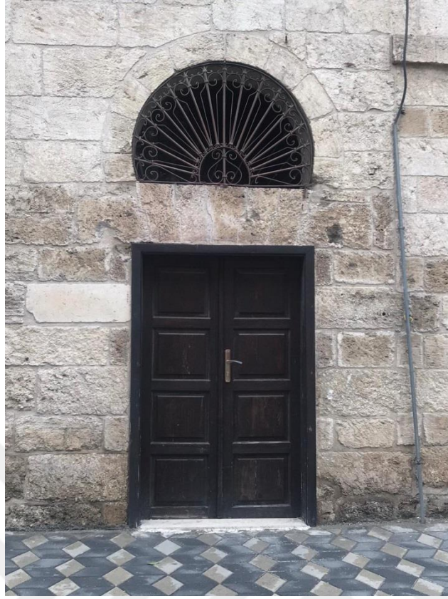
Resim 3.46. Toros Üniv. GSTMF A Blok Batı Cephe özgün kapı Foto: Tekin Banaz, 2020
