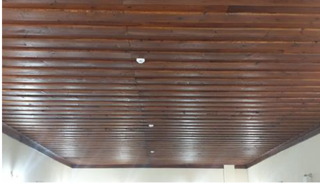
Resim 3.33./ Resim 3.34. Toros Üniv. GSTMF A Blok A102 ve A001 stüdyo derslikleri ahşap tavana gizlenmiş yangın algılama sistemi ve elektrik donatıları Foto: Tekin Banaz, 2020
