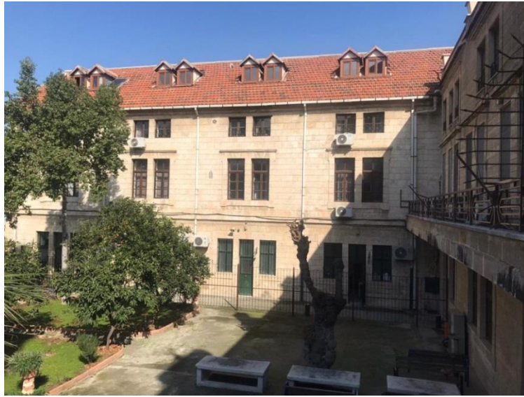
Resim 3.54. Toros Üniv. GSTMF B Blok Batı Cephe Foto: Tekin Banaz, 2020
