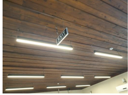
Resim 3.33./ Resim 3.34. Toros Üniv. GSTMF A Blok A102 ve A001 stüdyo derslikleri ahşap tavana gizlenmiş yangın algılama sistemi ve elektrik donatıları Foto: Tekin Banaz, 2020
