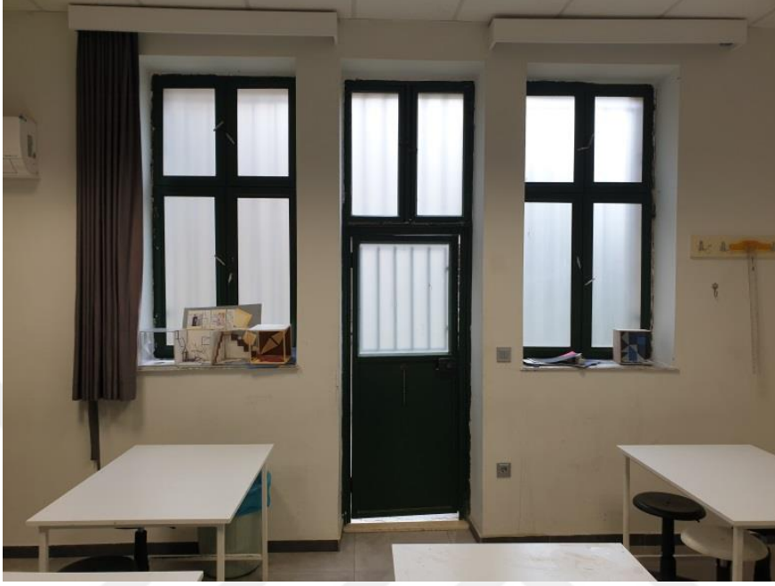
Resim 3.42. Toros Üniv. GSTMF B Blok B008 Zemin kat stüdyo pencere ve kapı Foto: Tekin Banaz, 2020
