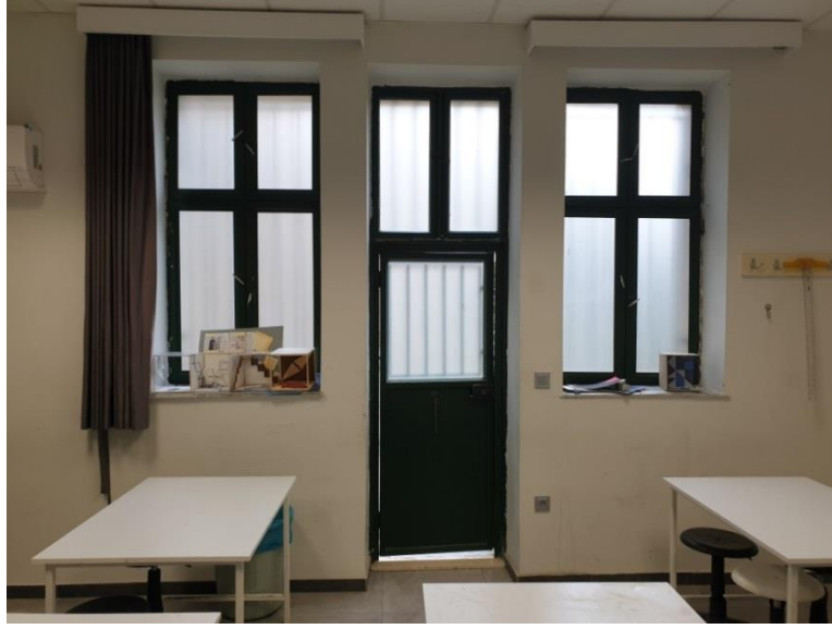
Resim 3.56. Toros Üniv. GSTMF B Blok zemin kat pencere- kapı iç mekan görünüşü
