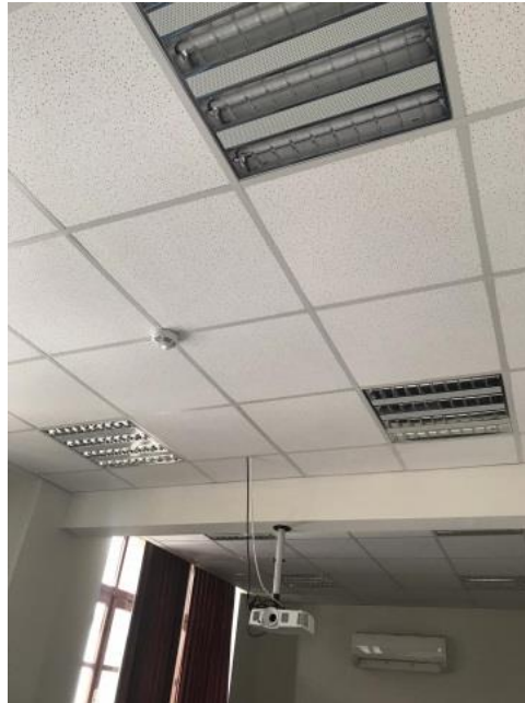
Resim 3.25. Toros Üniv.GSTMF B Blok Birinci Kat B103 Derslik Taşyünü Asma Tavan
