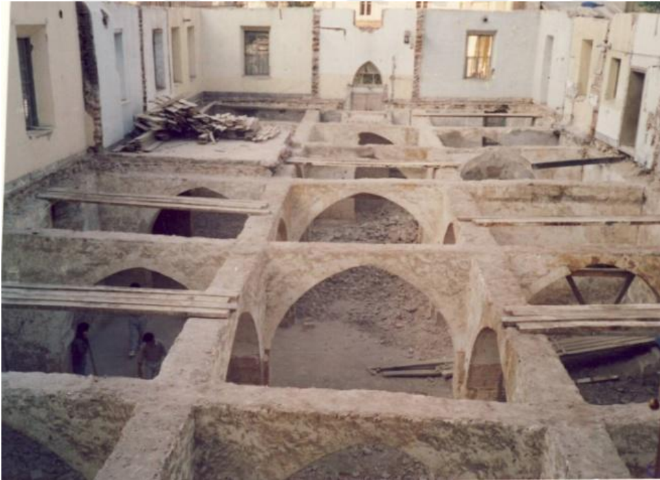
Resim 3.15. Kapusen Rahiplerinin Kaldığı Konut zemin kat kemerli yapı (Simonelli,2005)
