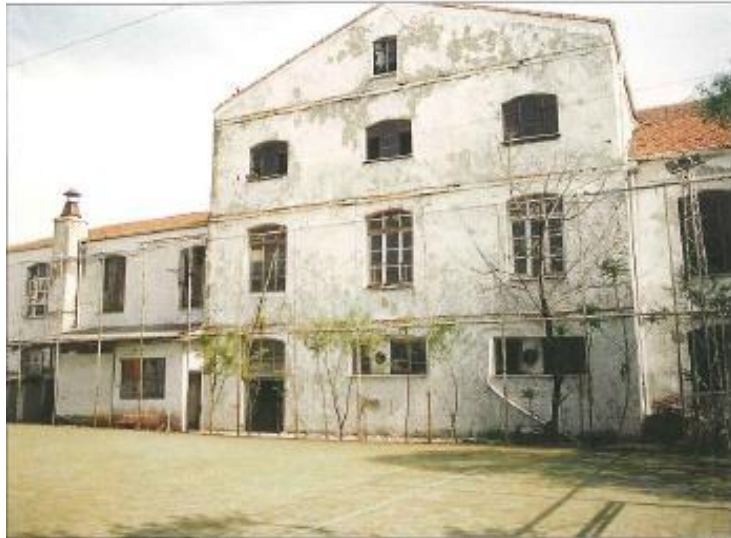
Resim 2.3. C Blok (O Blok) kuzey cephesi restorasyon öncesi, 2000 (Alper, 2019)
