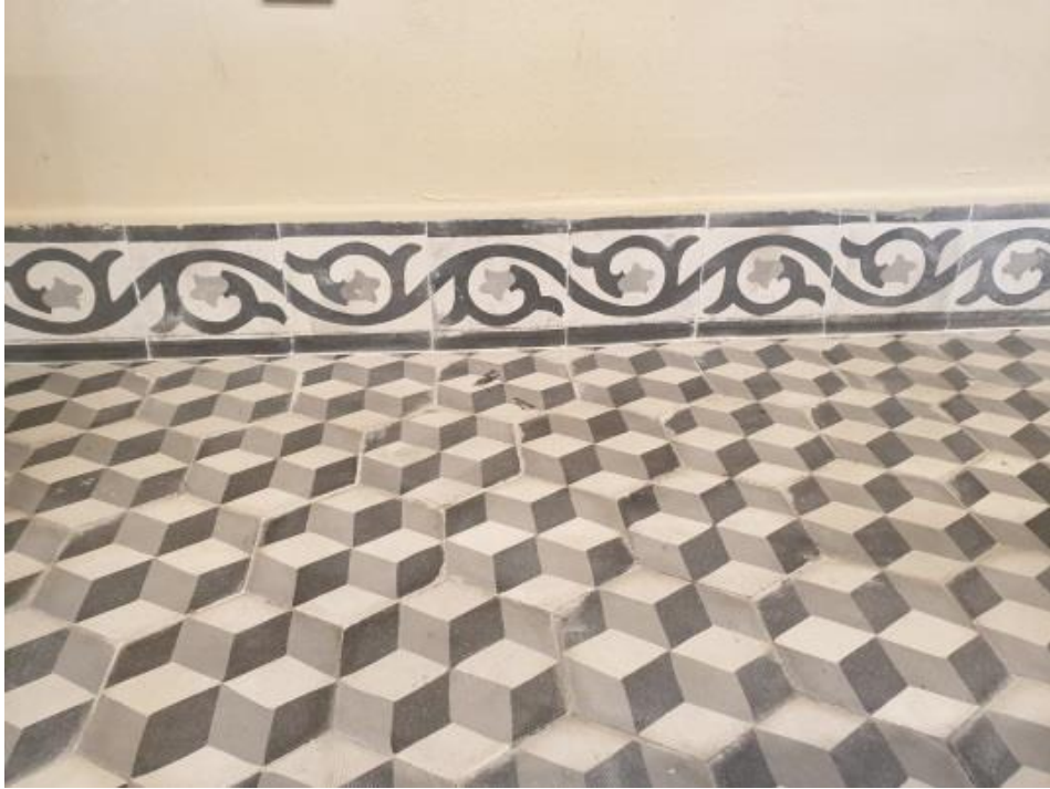
Resim 3.18.Toros Üniv. GSTMF A Blok Zemin kat A001 stüdyo derslik özgününe uygun üretilmiş karo mozaik Foto: Tekin Banaz,2020
