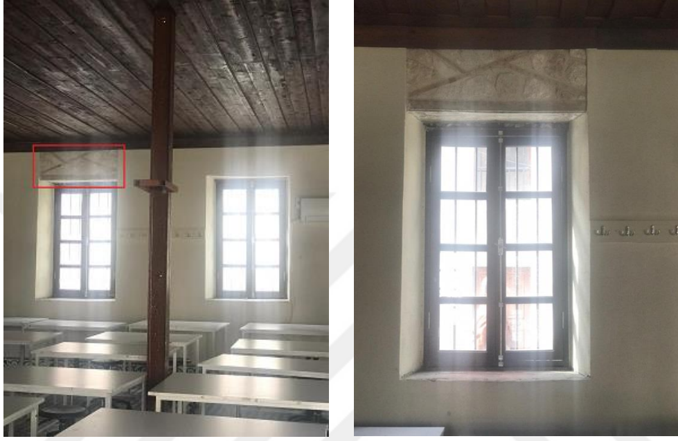
Resim 3.26./ Resim 3.27. Toros Üniv. GSTMF A Blok zemin kat atölyesinde pencere üstü açıkta bırakılmış malzeme detayı ve sağlamlaştırma için yerleştirilen çelik dikme Foto: Tekin Banaz, 2020
