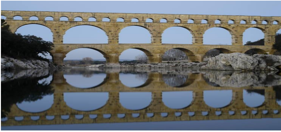
Şekil 4.6. Pont Du Gard Su Kemerini
