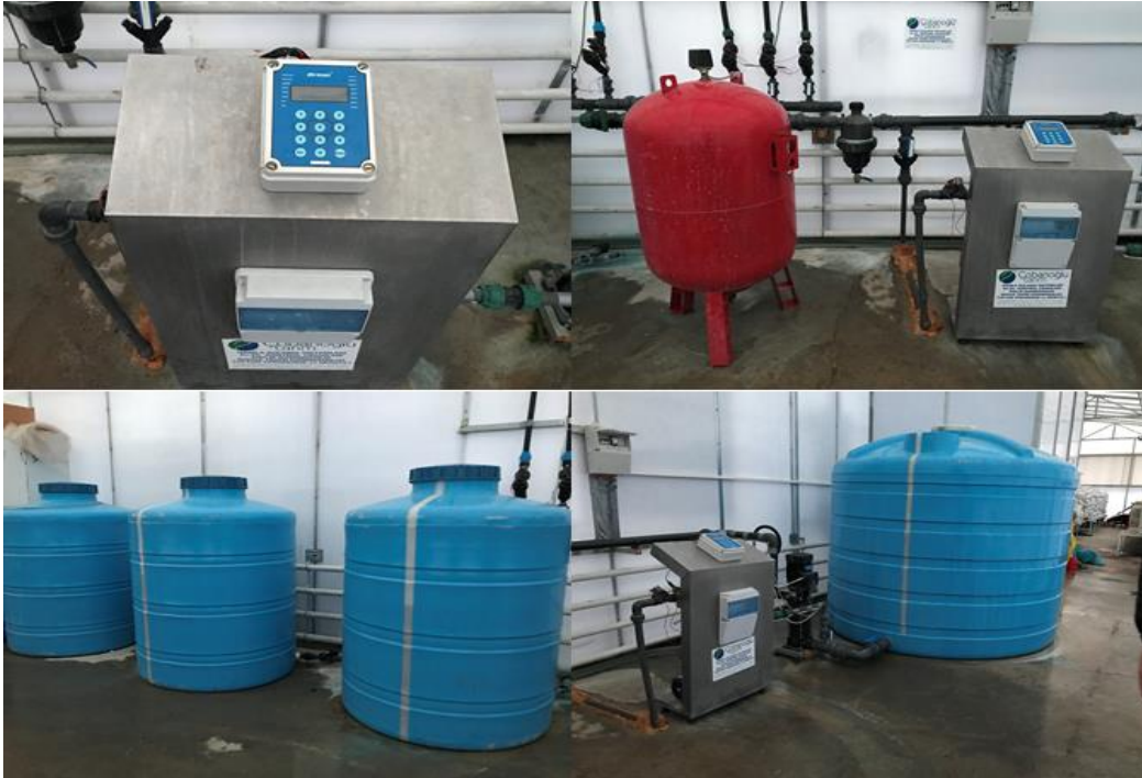
Şekil 3.9. Serada gübreleme ve sulama sistemleri
