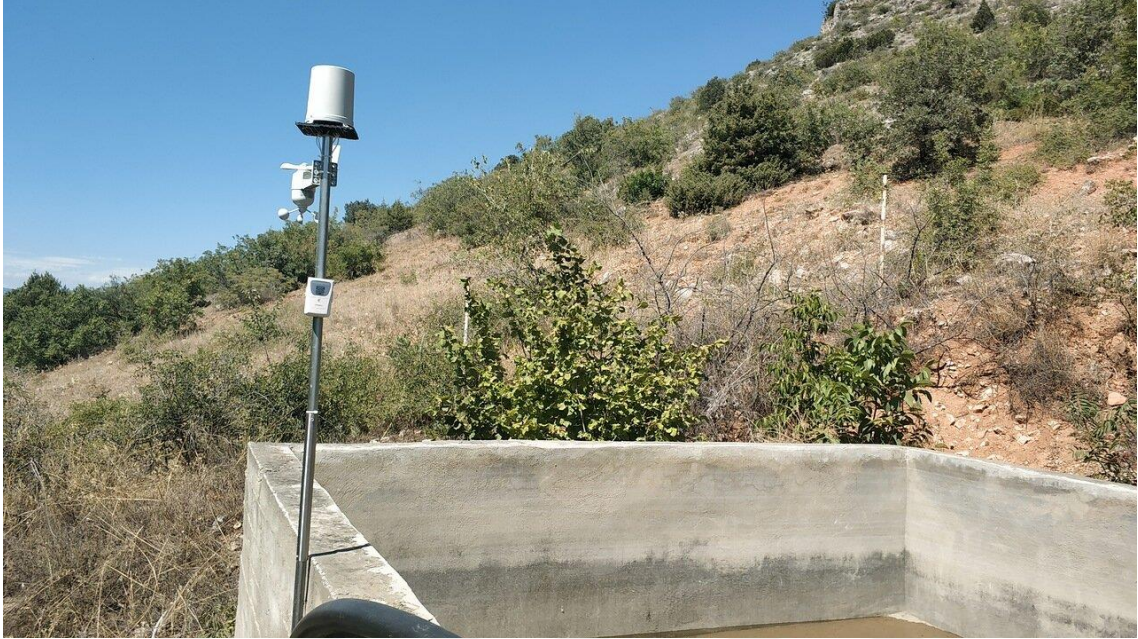
Şekil 4.6. WMU ünitesinin yerleştirilmesi
