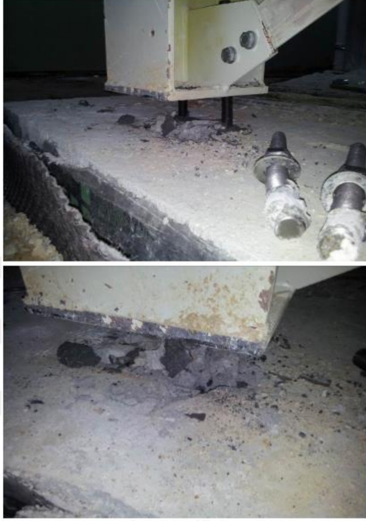
Şekil 5.3. Ankrajlara yetersiz epoxy sonrası durum.
