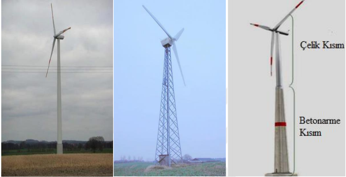
Şekil 3.14. Kule tipleri sırasıyla boru kesitli, kafes örgü ve hibrid kule (Genç, 2013)
