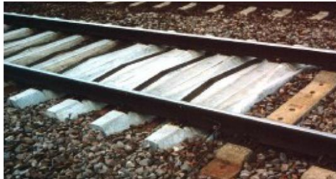
Şekil 2.60. Geniş traversli demiryolu (Esveld, 2014)
