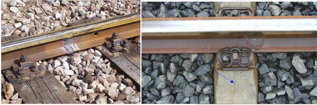
Şekil 2.69. Ray birleşim bölgesinde ahşap travers kullanımı (Soldaki: Anonim-f, 2019; Sağdaki: Németh, 2016)
