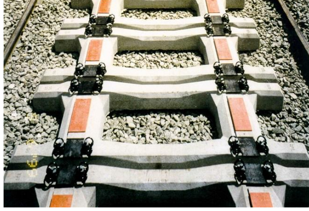
Şekil 2.62. Çift-H traversli (çerçeve) demiryolu (Esveld, 2014)
