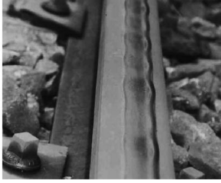
Şekil 2.15. Ray ondülasyonu kaynaklı titreşimler (Sol-Sánchez ve ark., 2015)
