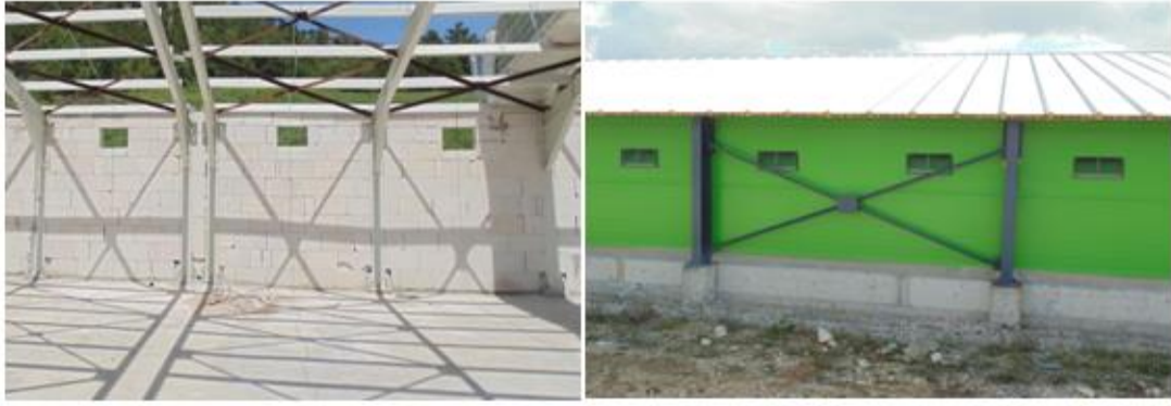
Şekil 4.6. Kümes duvarlarında uygulanan bims ve sandviç panel uygulamaları
