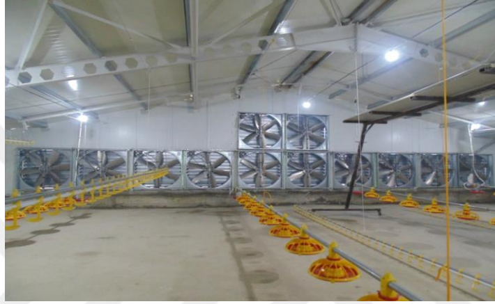
Şekil 4.9. Kümeslerde uygulanan havalandırma ve fan sistemleri görünümü
