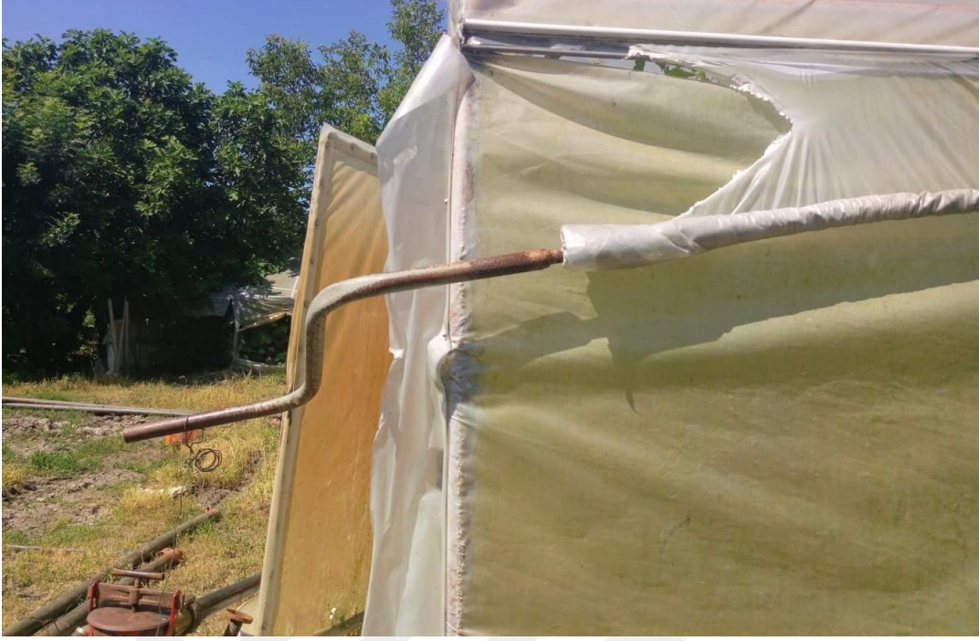
Şekil 4.11. Yan havalandırma açıklıklarının toplanmasında kullanılan mekanik toplayıcı
