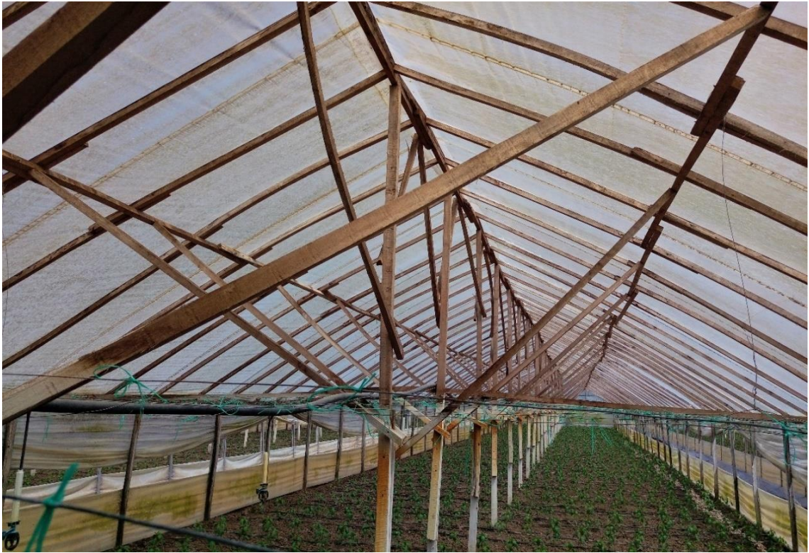
Şekil 4.3. Ahşap konstrüksiyonlu örtüaltı yapısı
