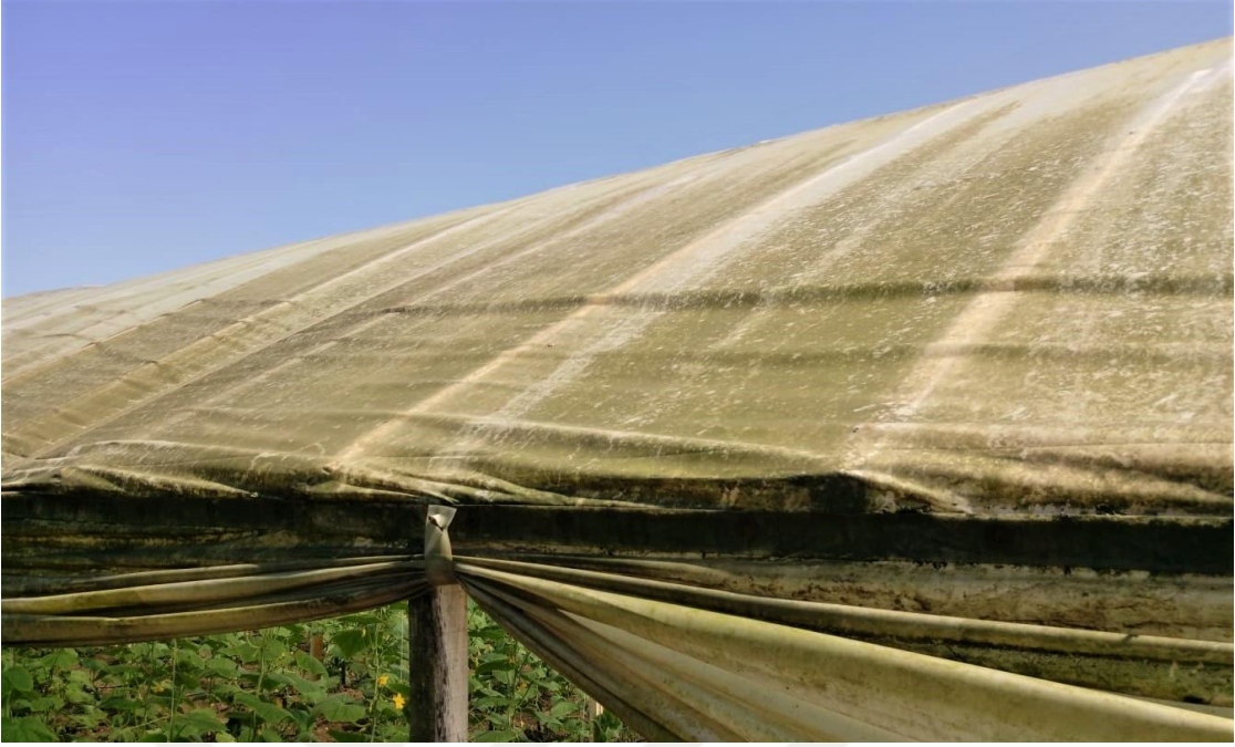
Şekil 4.8. Örtü malzemesinde toz birikimi
