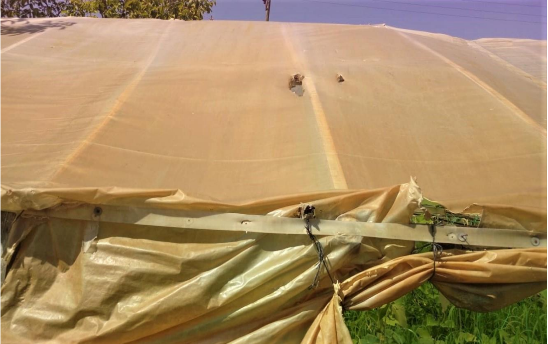
Şekil 4.5. Örtü malzemesinde oluşan deformasyon
