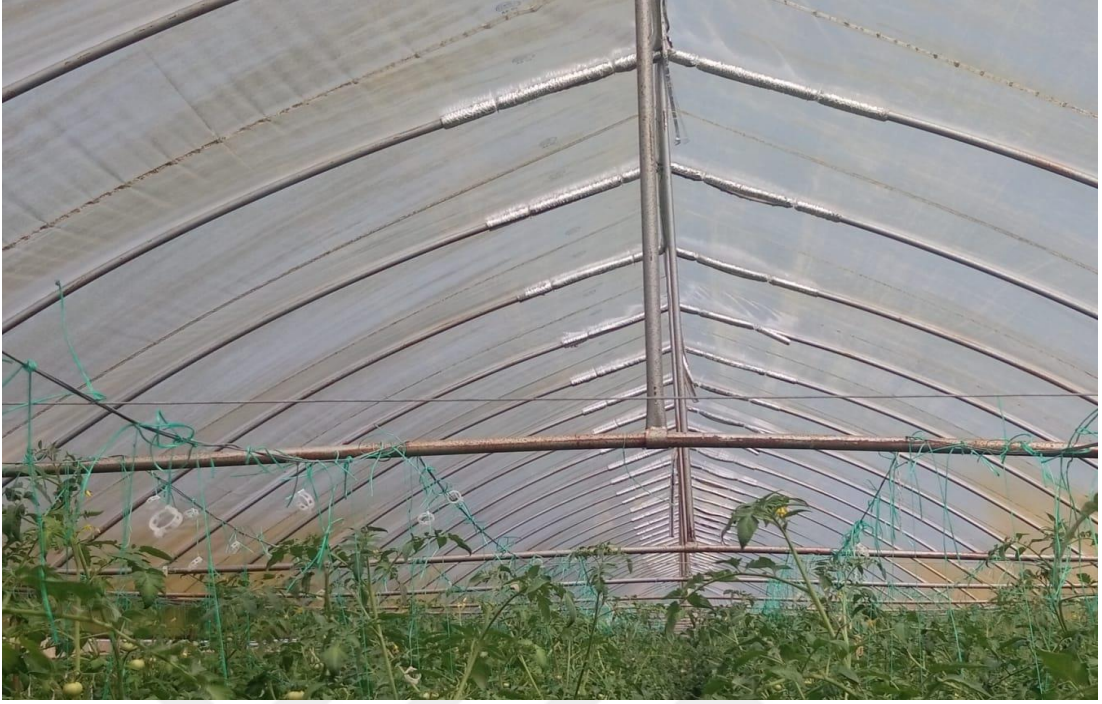
Şekil 4.4. Demir konstrüksiyonlu örtüaltı yapısı
