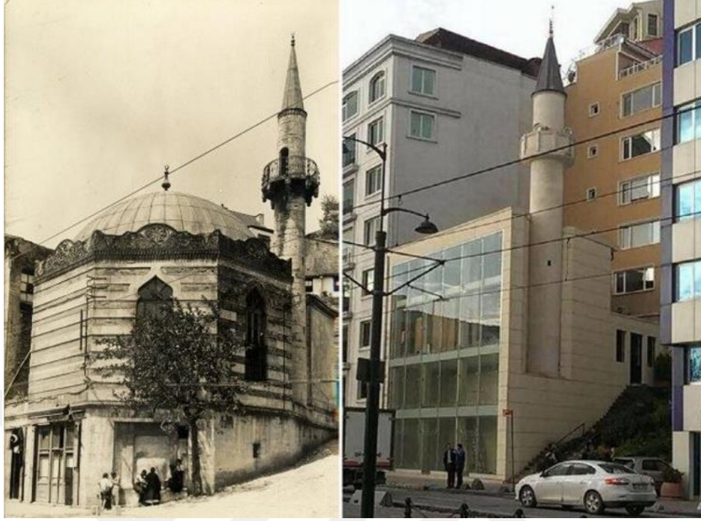
Şekil 3.16.Süheyl Bey Caminin Restorasyon Öncesindeki ve Sonrasındaki Hali
