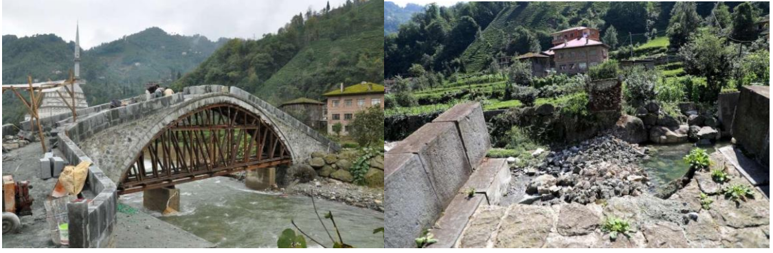
Şekil 3.14.Köprü'nün Restorasyondan Sonrası Hali ve Yıkılmış Hali
