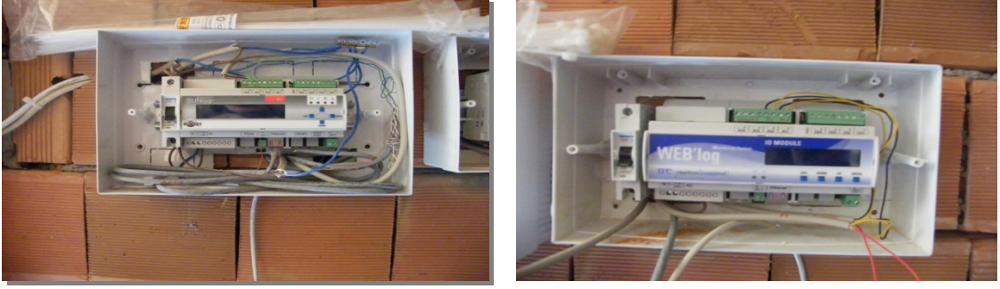
Şekil 3.3. Sistemde kullanılan SUNlog XL veri kaydedici ve uzaktan izleme için WEBlog cihazı
