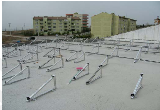
Şekil 3.1. Batman Özel Çözüm Kolejine kurulan sistemin montajlama süreci
