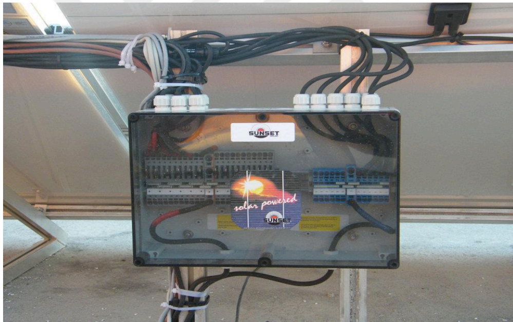
Şekil 3.6. Kablo bağlantıları (JustenBox Kutusu)
