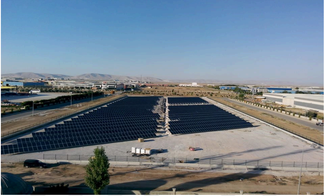
Şekil 2.6. Konya Organize Sanayi Bölgesi 1Megawatt Güneş Enerji Santrali
