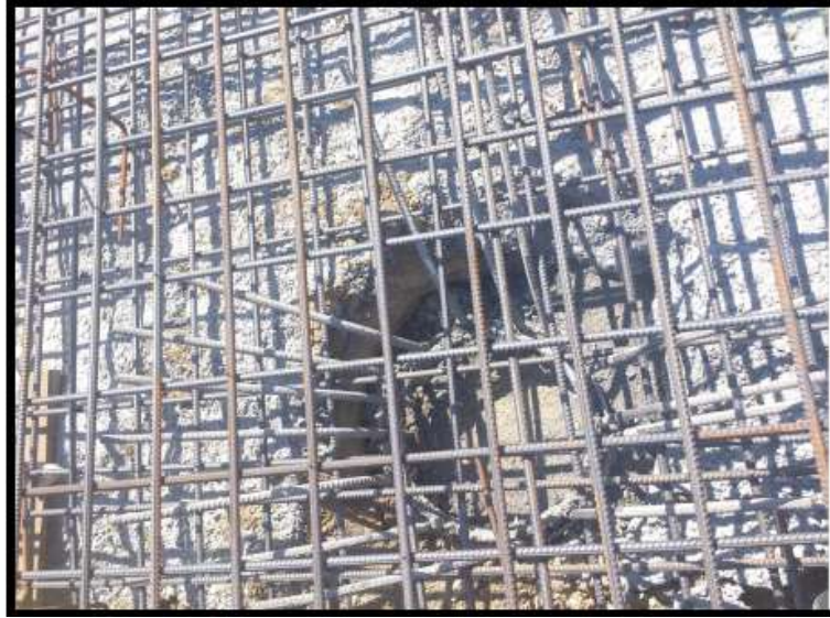
Şekil 3.50. Fore kazık filizlerinin radye temelle birleştirilmesi.
