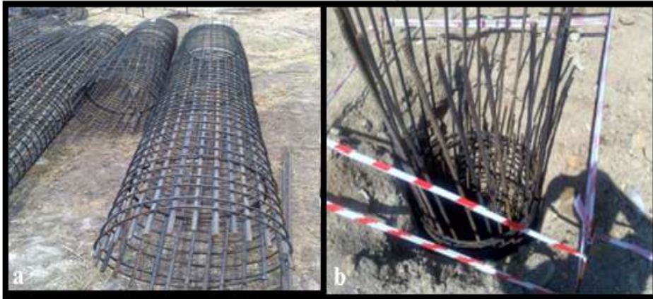
Şekil.3.48. a) Daire kesitli donatılar b) Baca kazılarının içine yerleştirilmiş bir donatı.
