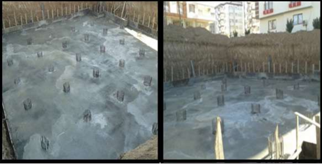
Şekil 3.49. Bacalar ve buldukları düzlem üzerine beton dökülmesi
