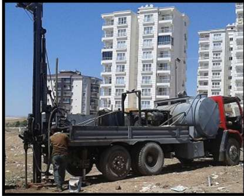
Şekil 3.1. İnceleme alanında yapılan sondaj çalışması
