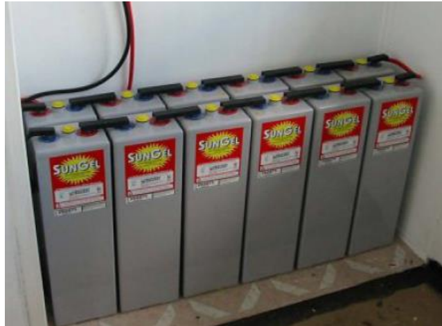
Şekil 2.15. Fotovoltaik sistem için tasarlanmış akü grubu
