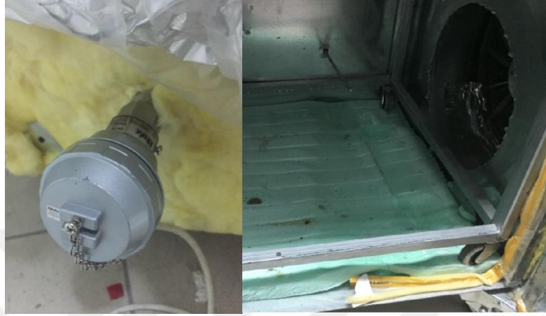
Şekil 3.8. PT-100 sıcaklık algılayıcısı
