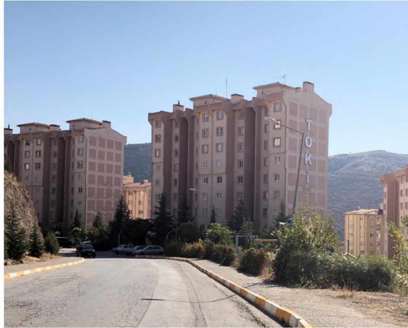
Şekil 3.12. F Blok cephe görünüşü
