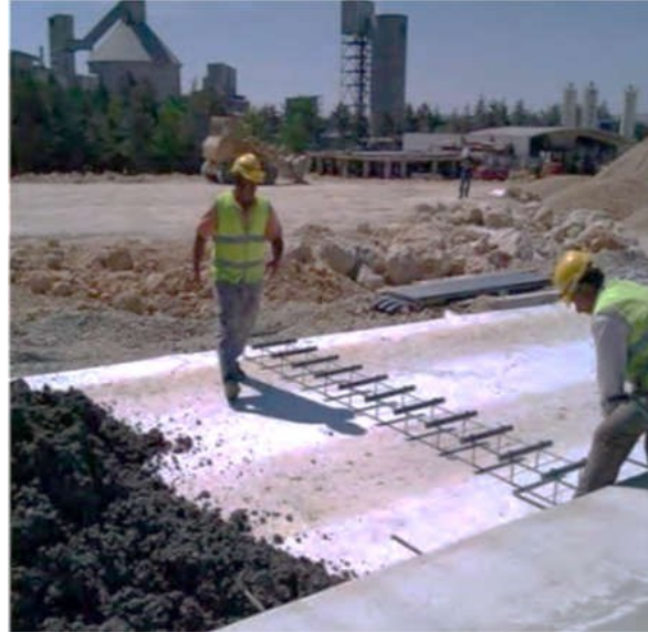
Şekil 2.11. Kayma demirleri yerleştiriliyor(Gülen Şahin ve ark., 2016).
