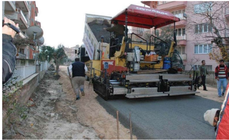
Şekil 2.17. Denizli beton yol çalışması(Yaman ve Ceylan, 2015)
