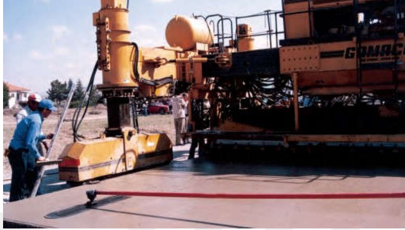
Şekil 2.6. Kaplama yüzeyinin masterlanması(Yeniboğanlı, 2010)
