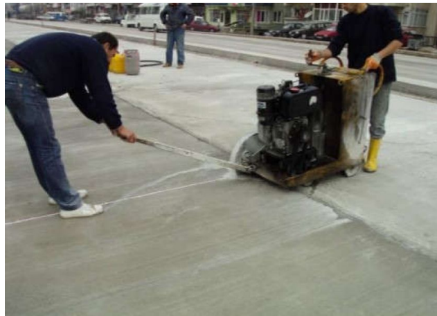
Şekil 2.15. Derz kesimi (Abut, 2018)
