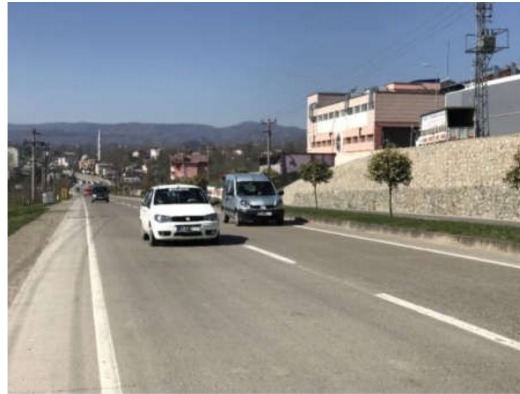
Şekil 2.13. Ordu - Ulubey yolu, beton yol kesimi(İHA, 2019)
