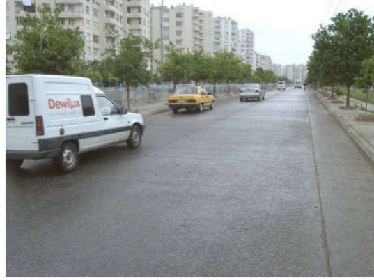
Şekil 2.4. İncirlik hava üssü çevre güvenlik yolu beton dökümü(Ecevit, 2007).
