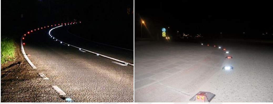
Şekil 2.7. Reflektif yol butonu uygulaması örneği
