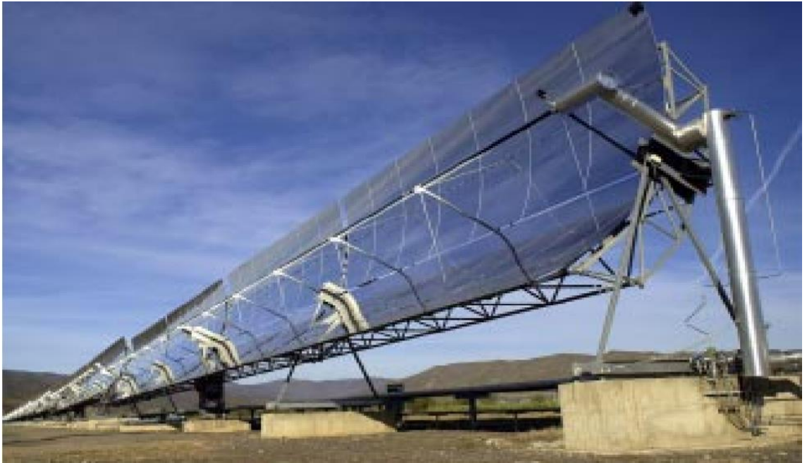
Şekil 2.2. Parabolik oluk sistemlerine bir örnek (Zarza ve ark., 2002)
