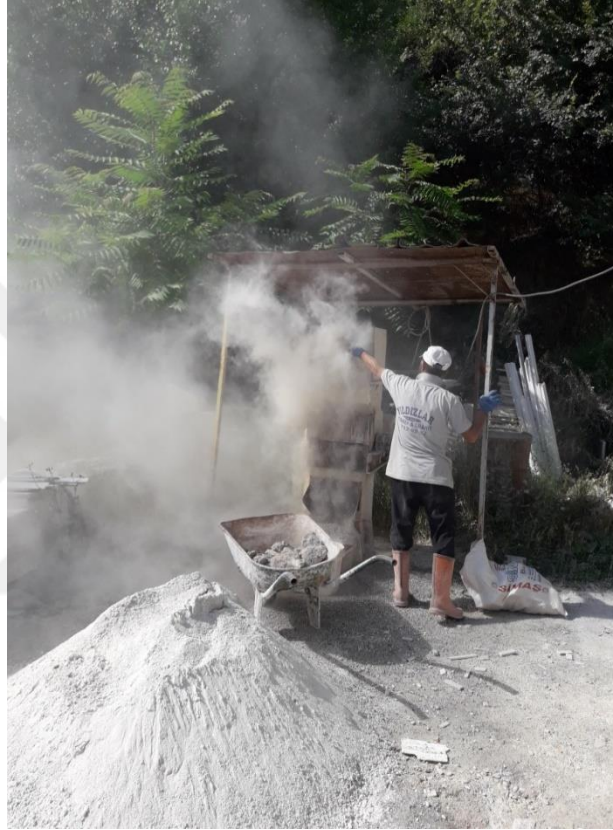
Şekil 3.4. Beton atıklarının öğütülmesi
