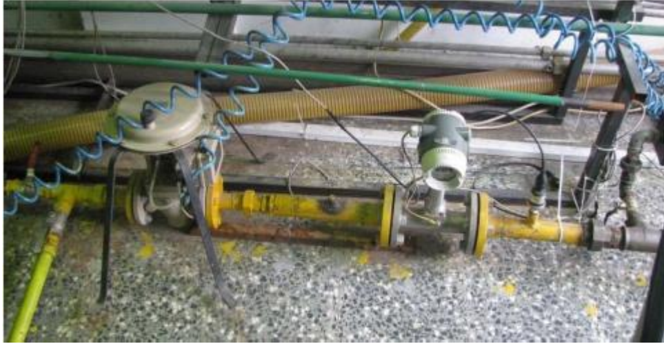
Şekil 3.18 : Fisher Kontrol Vanası Ve Toshiba Akış Ölçer
