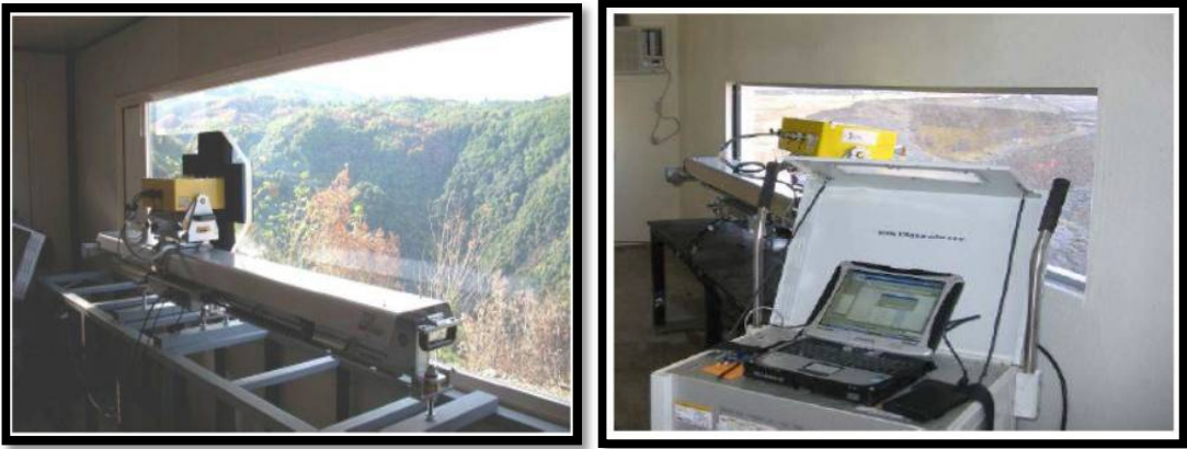
Şekil 3.11. Şev izleme istasyonu izleme ünitesi ve monitörü
