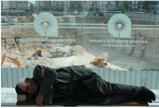
Picture 7. 26. Doğu Garajı Temel Kazısı Çalışmaları Source: Ercüment Güllübağçe
