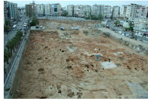
Picture 7. 27. Doğu Garajı Temel Kazısı Çalışmaları
