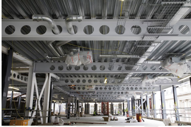
Resim 1.2: I-kesitli kirişin inşaat sektöründe kullanımı (Tsavdaridis 2010).
