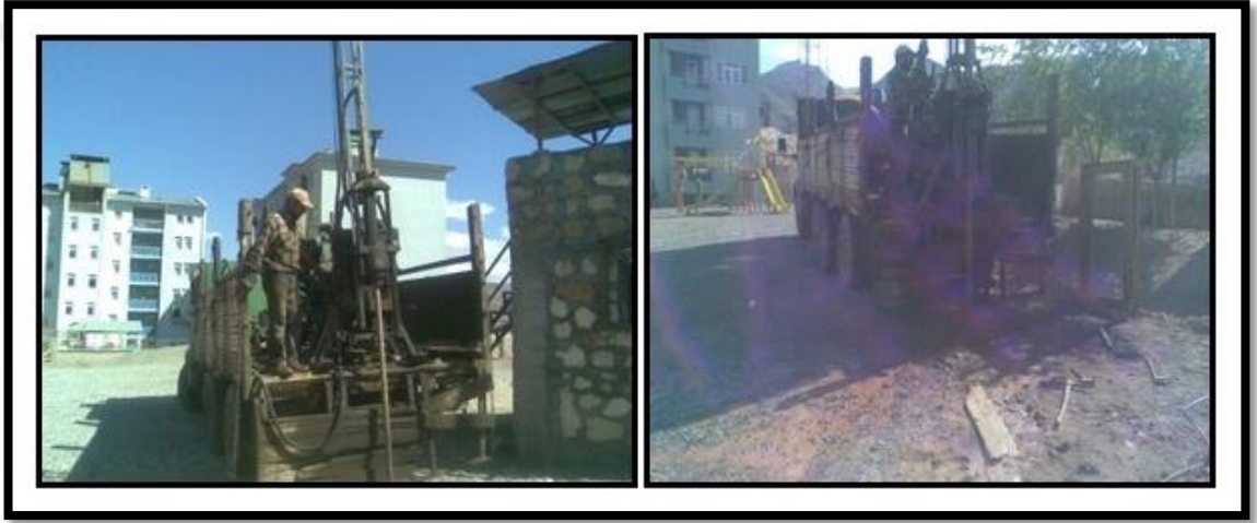
Şekil 5.2. İnceleme alanında yapılan sondaj çalışmaları.
