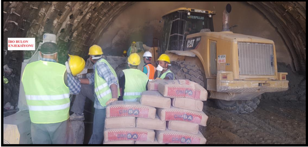
Şekil 4.50. İnceleme alanı T4 Tüneli ibo bulon enjeksiyon çalışması
