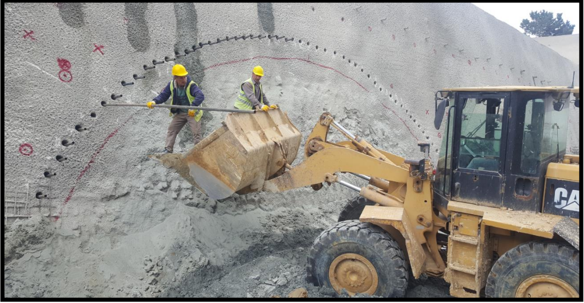
Şekil 4.38. İnceleme alanı T4 Tüneli tünel portal girişinde boru süren uygulaması
