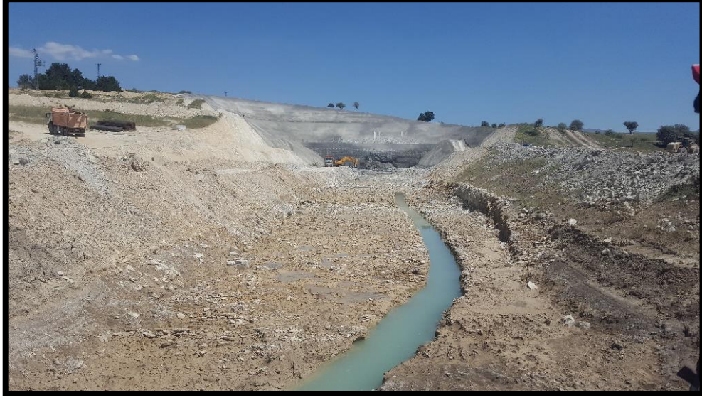
Şekil 4.5. Tünel alanı güzergah görüntüsü
