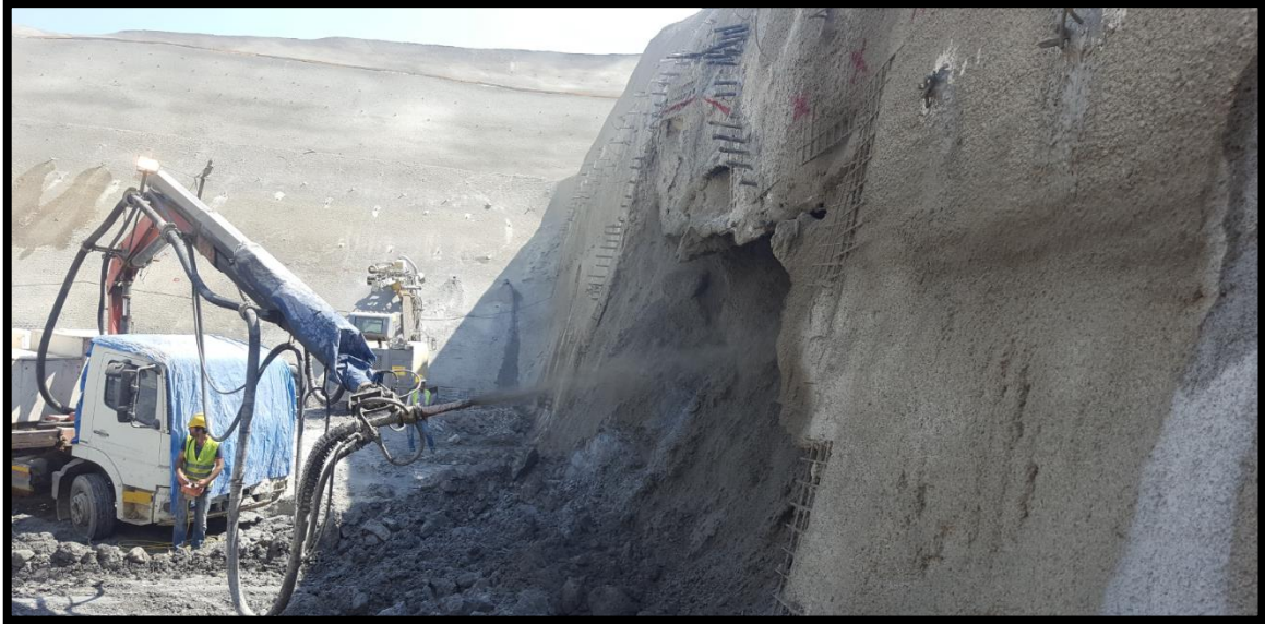
Şekil 4.42. İnceleme alanı T4 Tüneli giriş portalında emniyet shotcrete uygulaması
