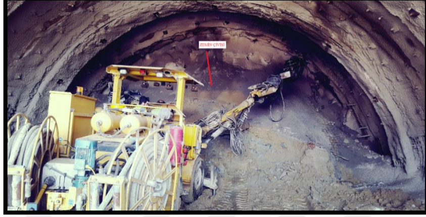
Şekil 4.39. İnceleme alanı T4 Tüneli zemin çivisi uygulaması
