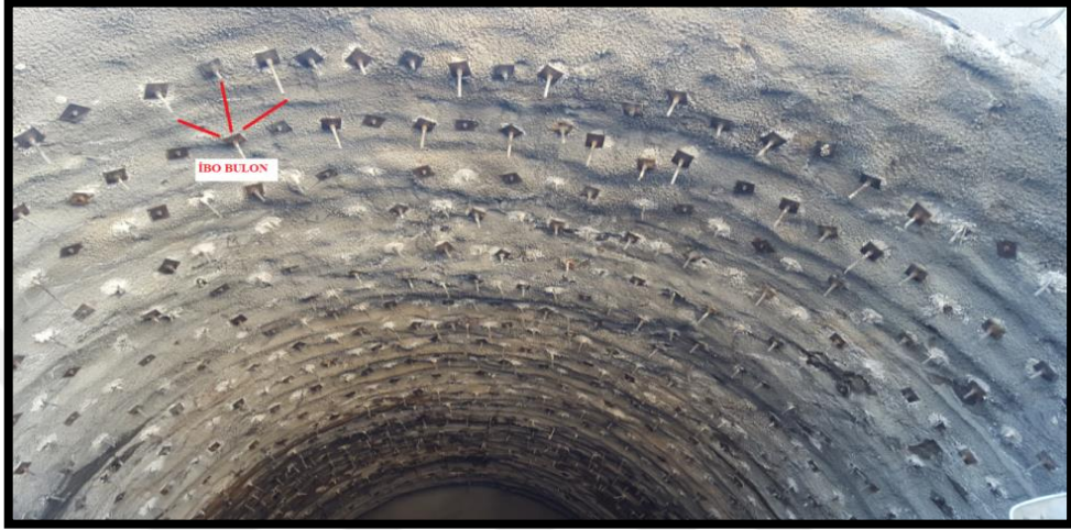
Şekil 4.48. İnceleme alanı T4 Tüneli içerisindeki sistematik yerleşim ibo bulon görünümü
