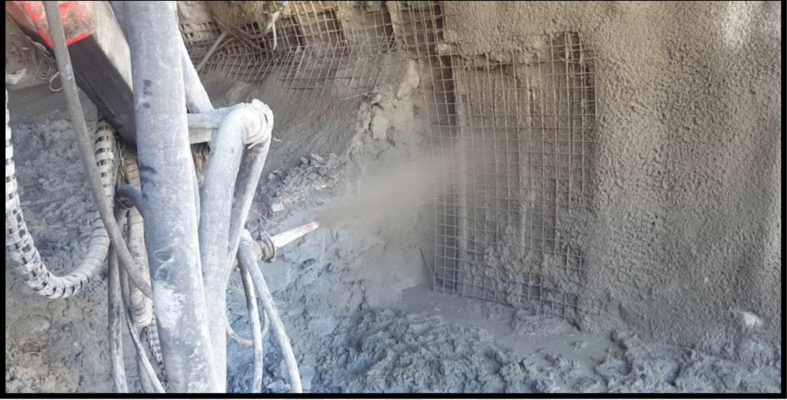
Şekil 4.44. İnceleme alanı T4 Tüneli alt yarı beton püskürtme uygulaması
