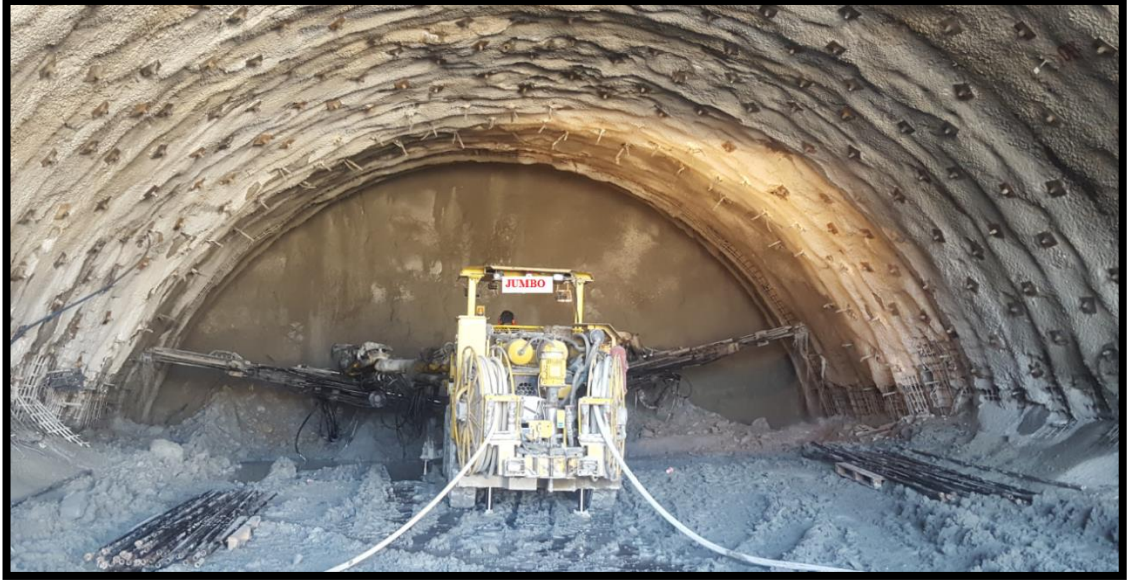
Şekil 4.31. Tünel içerisinde Jumbo çalışması
