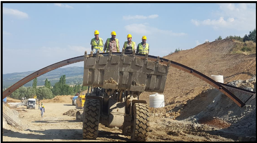
Şekil 4.33. İnceleme alanı T4-tünelindeki iksa (Ø – 160) taşınması
