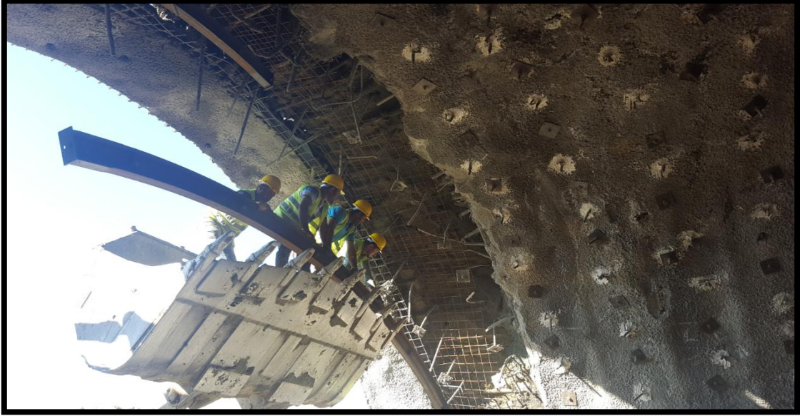
Şekil 4.13. İnceleme alanında tünel kesitindeki sökülen iksaların yerine yapılan iksa montajı
