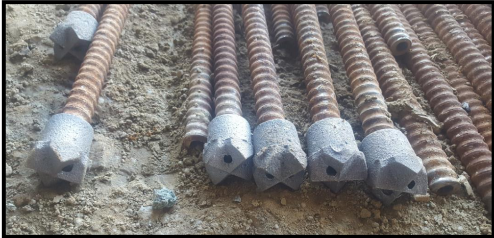
Şekil 4.49. İnceleme alanı T4 Tüneli ibo bulon hazırlığı
