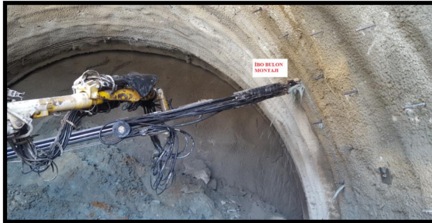
Şekil 4.47. İnceleme alanı T4 Tüneli ibo bulon delgi montajı
