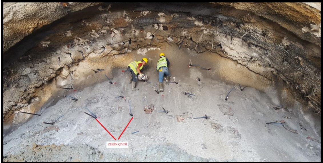
Şekil 4.40. İnceleme alanı T4 Tüneli aynada zemin çivisi ve alçılanması çalışması
