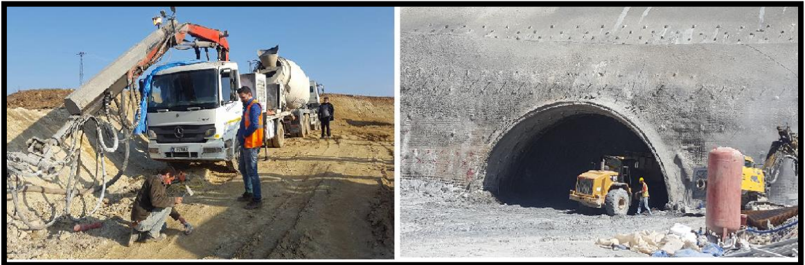
Şekil 4.6. İnceleme alanında yapılan çalışma görüntüsü
