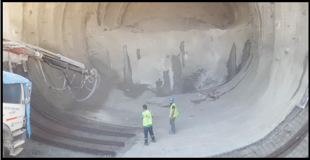
Şekil 4.45. İnceleme alanı T4 Tüneli invert (taban)
