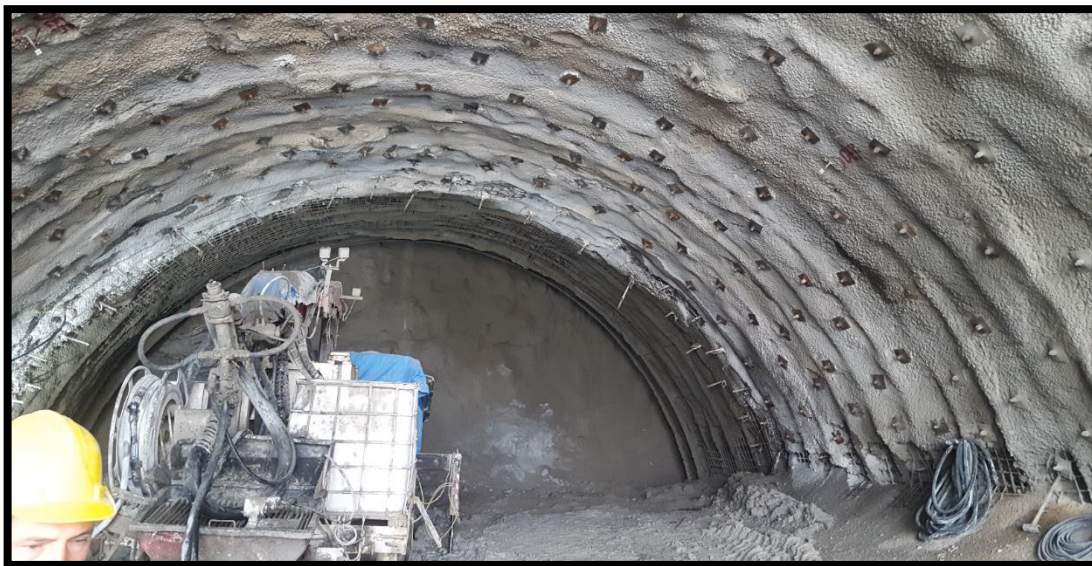
Şekil 4.43. İnceleme alanı T4 Tüneli iksa yüzeyine atılan püskürtme beton
