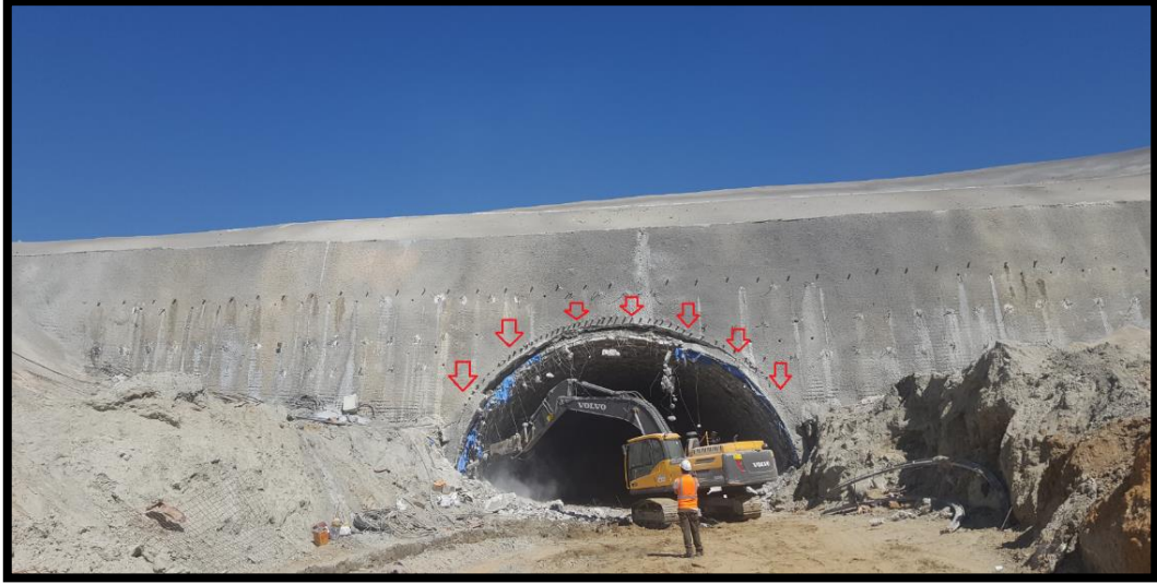
Şekil 4.11. İnceleme alanında tünel kesitindeki ilk iksa sökümü (Ø 200)
