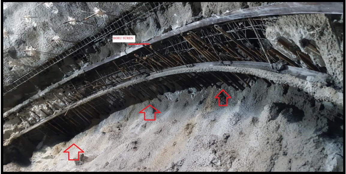
Şekil 4.37. İnceleme alanı T4 Tüneli boru süren uygulaması
