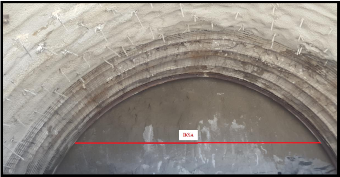
Şekil 4.32. İnceleme alanı T4-tünelindeki iksa (Ø – 160) montajı
