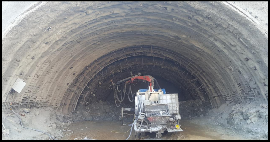
Şekil 4.41. İnceleme alanı T4 Tüneli Püskürtme Beton Uygulaması
