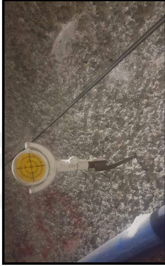
Şekil 4.10. İnceleme alanında tünel kesitindeki deformasyon ölçüm reflektörü
