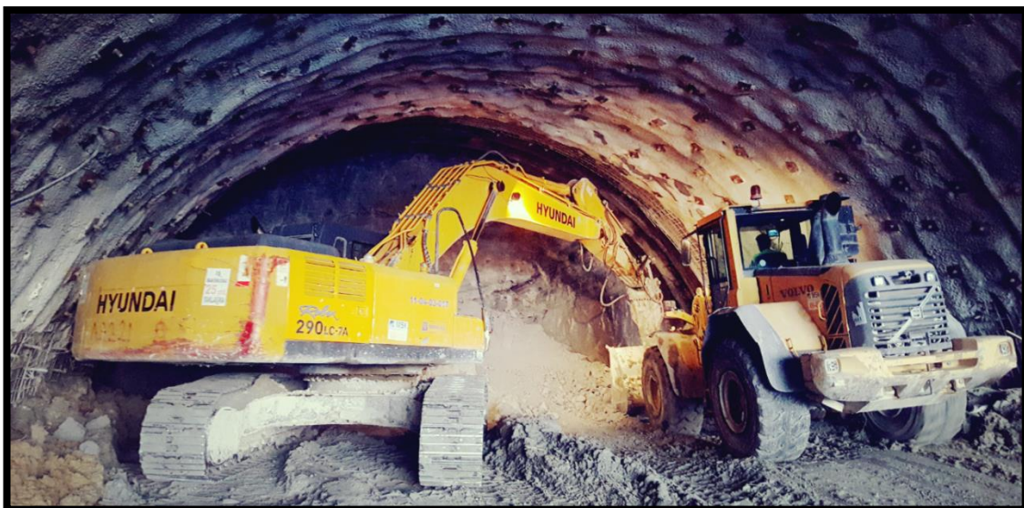
Şekil 4.30. Tünel içerisinde kazı ve pasa alımından bir görüntü
