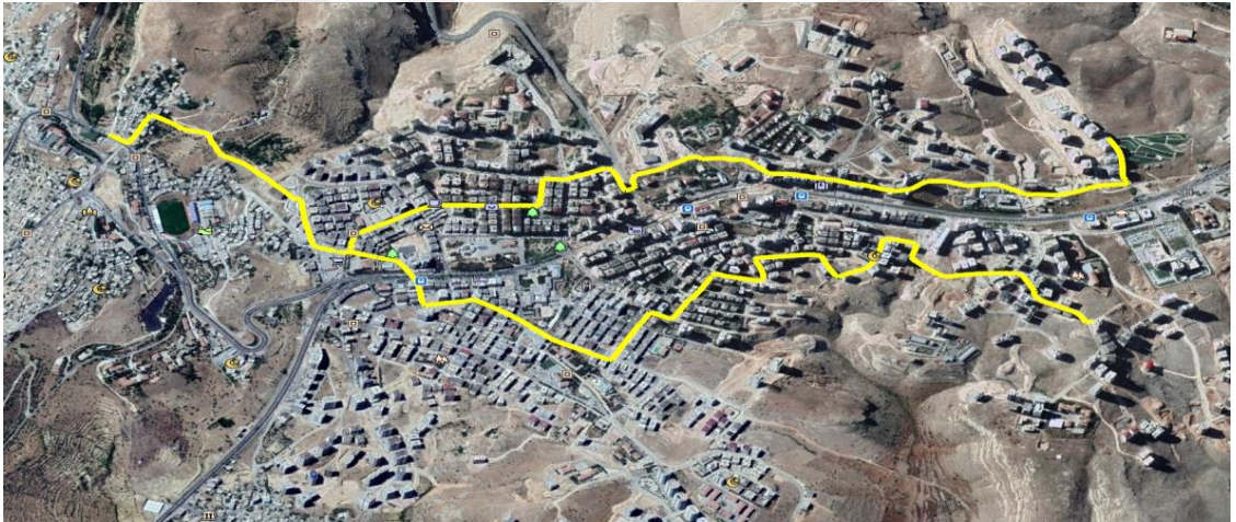
Şekil 5.1 Mardin ili 8 inç doğalgaz boru hattı uydu görüntüsünden
