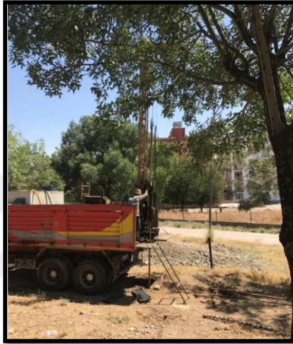
Şekil 4.4. İnceleme alanında yapılan sondaj çalışması
