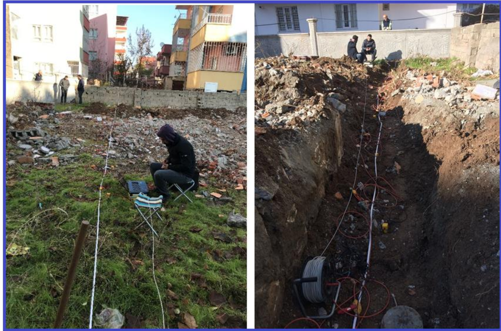
Şekil 4.45. İnceleme alanında yapılan sismik yöntem ölçüm çalışmaları
