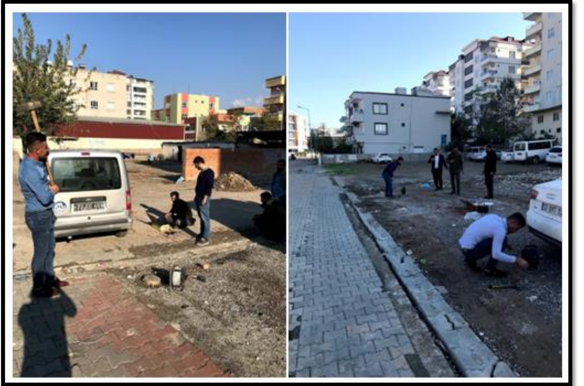
Şekil 4.32. İnceleme alanında yapılan sismik yöntem ölçüm çalışmaları
