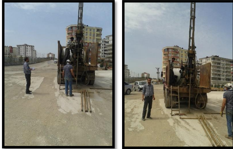
Şekil 5.6. İnceleme alanında yapılan sondaj çalışmaları.
