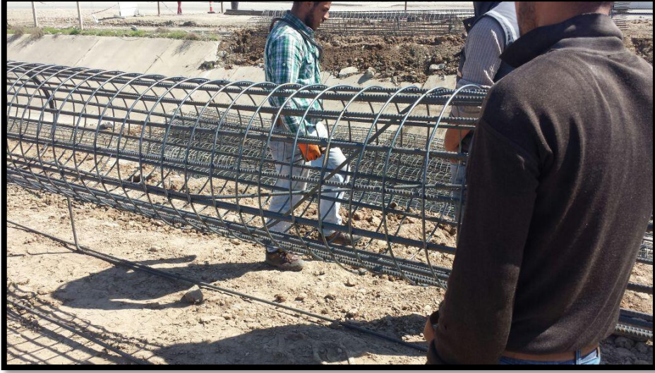
Şekil 5.23. Daire kesitli donatılar.
