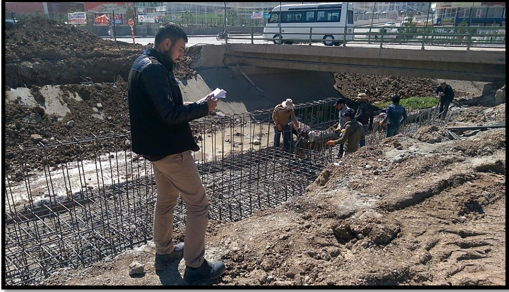
Şekil 5.25. Fore Kazık filizlerinin Temelle birleştirilmesi.
