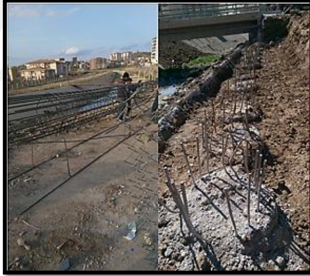
Şekil 5.24. Baca kazılarının içine yerleştirilmiş donatılar.
