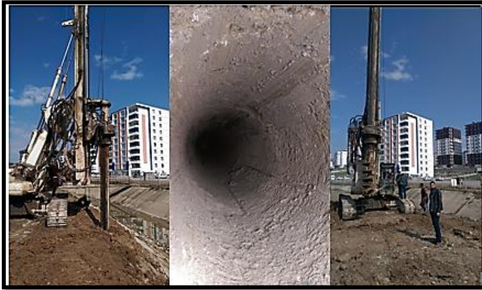
Şekil 5.22. İnceleme alanında açılan delgiler.
