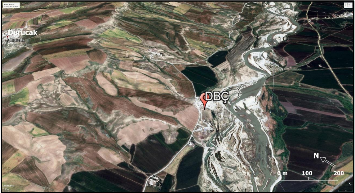
Şekil 6.58. Durucak (Bımır) konkasörü (DBÇ)' ne ait lokasyon görüntüsü (Google Earth'den değiştirilerek)
