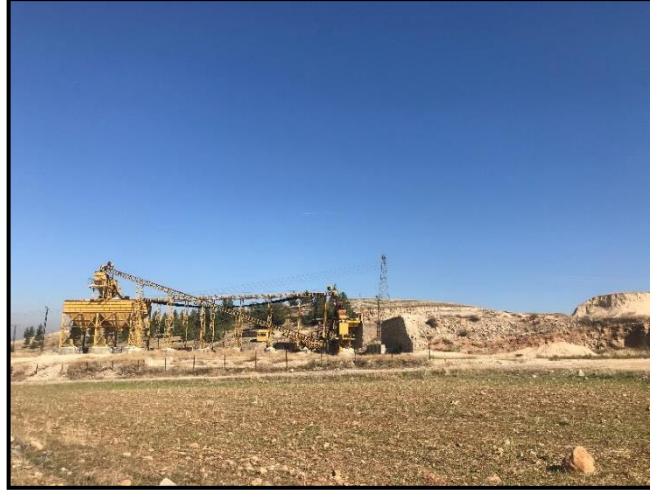
Şekil 6.17. DHK-2 numune noktasında bulunan terkedilmiş konkasör
