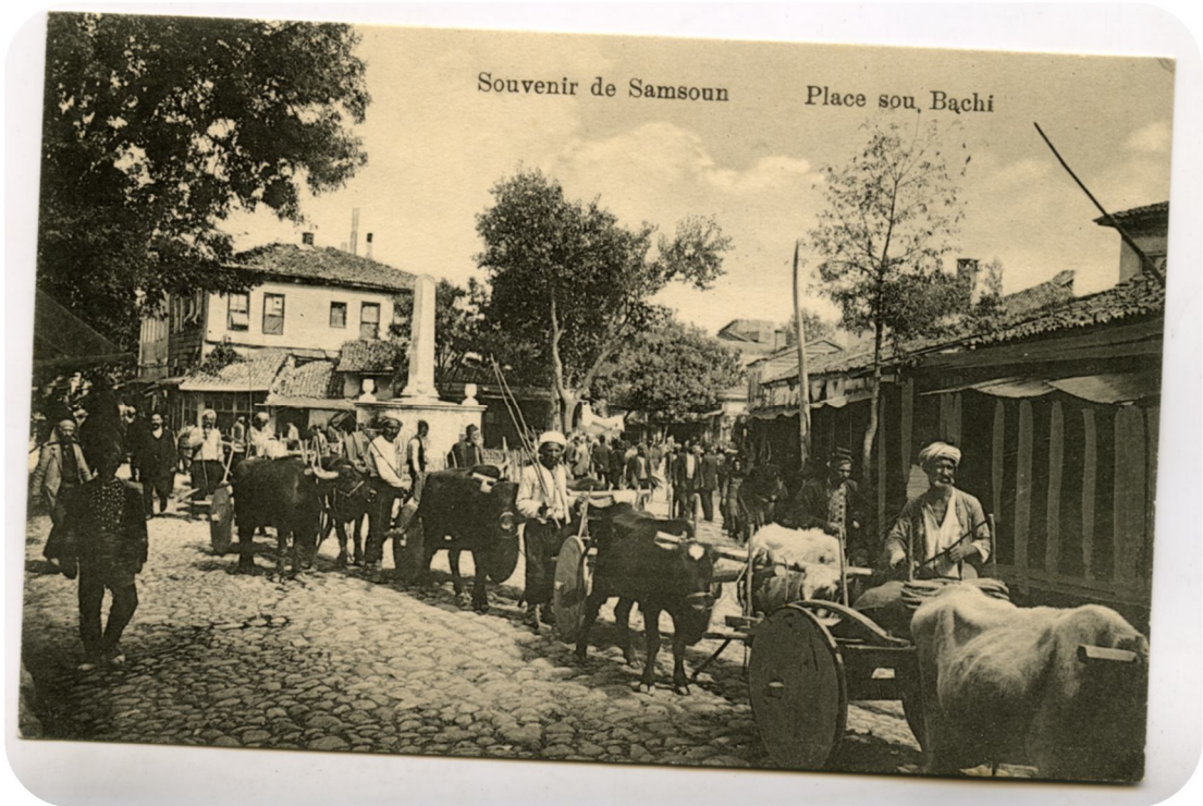
Fotoğraf 29: İsmail Bey ibn-i Namık ve Zevcesi Bakiye Hanım Çeşmesi (Tahminen, SBBA.)
