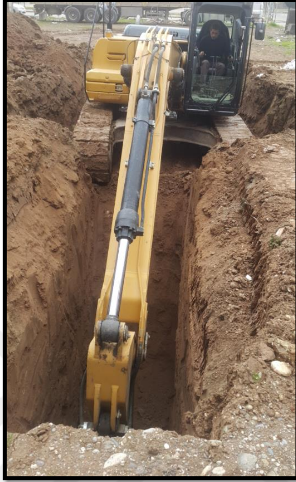
Şekil 5.16. Babil Apartmanı ve Serhat Apartmanı arasında kalan boş alanda açılan araştırma çukuru görüntüsü
