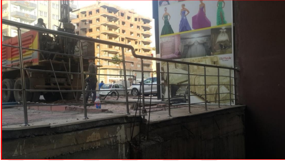
Şekil 5.3. Babil apartmanı L-1 numaralı sondaj kuyusuna ait çalışmalar
