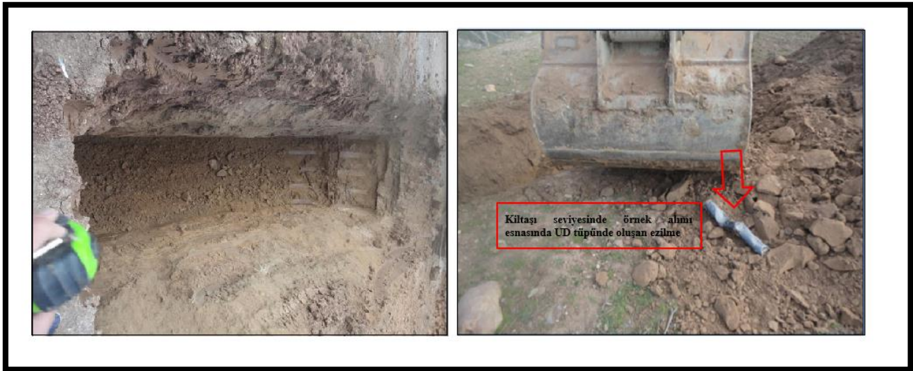
Şekil 5.23. Yaşar Kemal Kent Ormanı içinde 24.02.2018 tarihinde açılan araştırma çukurunda kıltaşı seviyesinden alınmaya çalışılan UD örnek'te Shelby tüpünde oluşan ezilme
