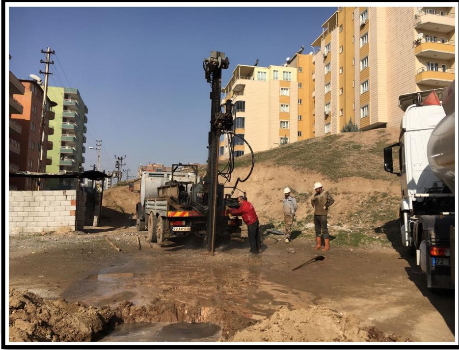
Şekil 5.21. Dünya Hastanesi Doğu tarafında GZ-1 numaralı sondaj kuyusuna ait çalışmalar
