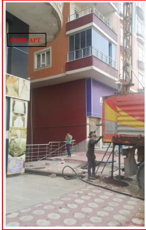
Şekil 5.4. Babil apartmanı L-1 numaralı sondaj kuyusuna ait çalışmalar
