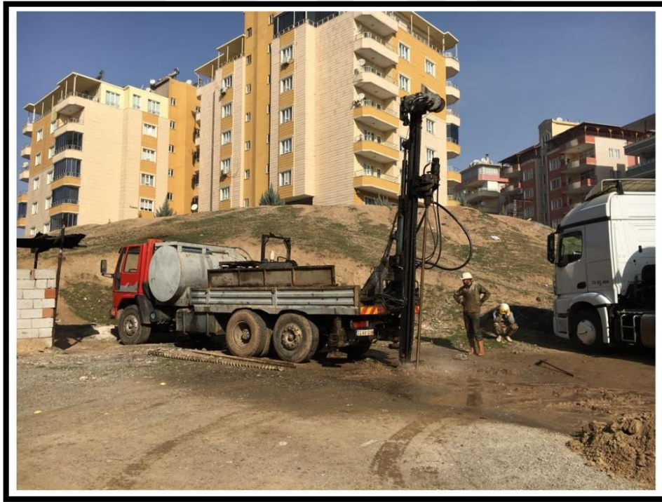
Şekil 5.20. Dünya Hastanesi Doğu tarafında GZ-1 numaralı sondaj kuyusuna ait çalışmalar
