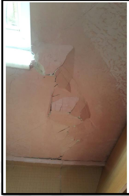
Şekil 5.9. Babil apartmanında gözlenen taşıma gücü ve oturma deformasyonları
