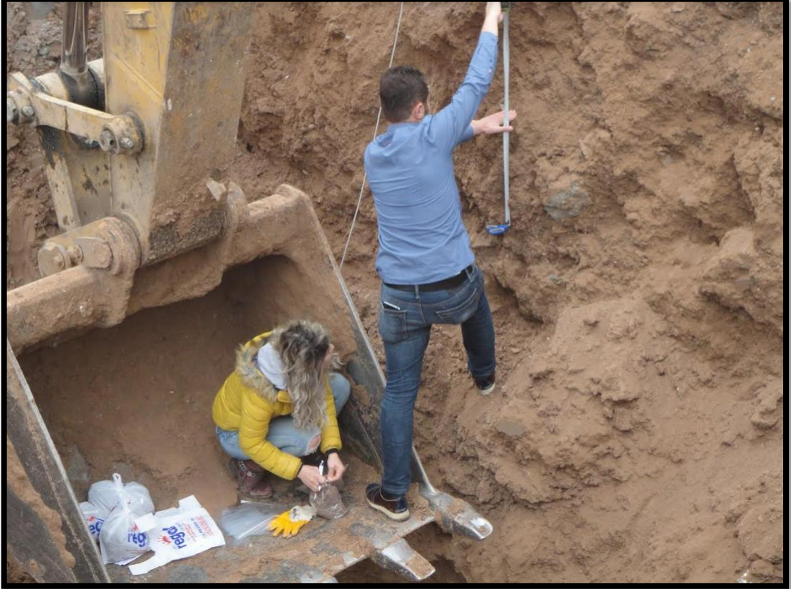
Şekil 5.5. Babil Apartmanında araştırma çukuru açılması sırasındaki örnek alımı çalışmaları
