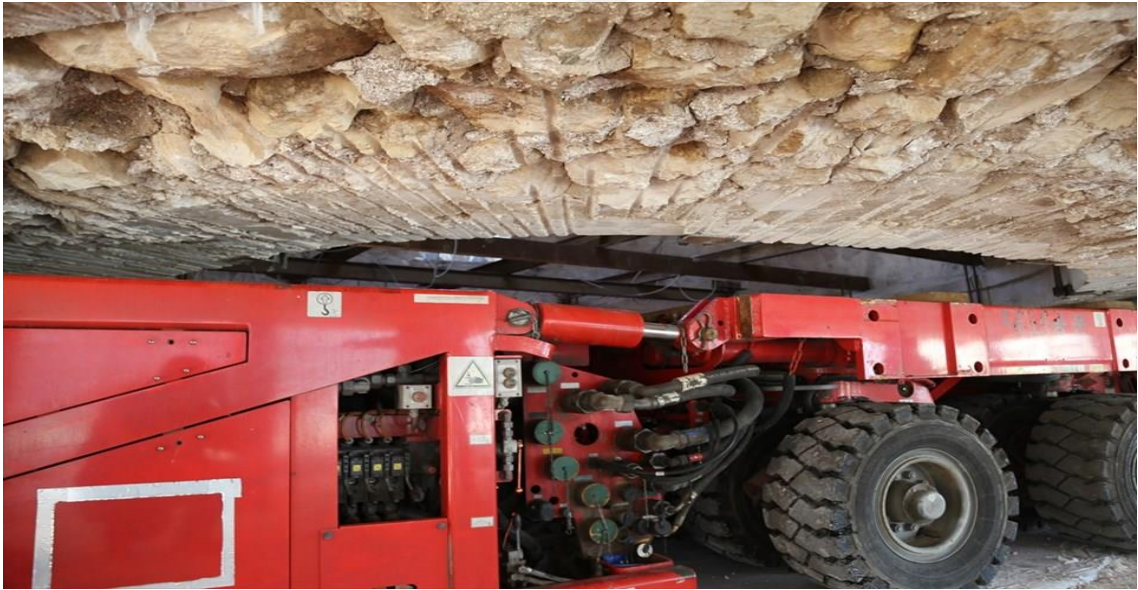
Şekil 3. 7. Zeynel Bey Türbesinin Taşınma işlemi. ( https://www.ntv.com.tr/galeri/sanat/tarihi-zeynel-bey-turbesi-tasindi,b0b56QPw9U-2A4yZIXArwQ/p7bCaPmVF0SXv3TlrAic9A )
