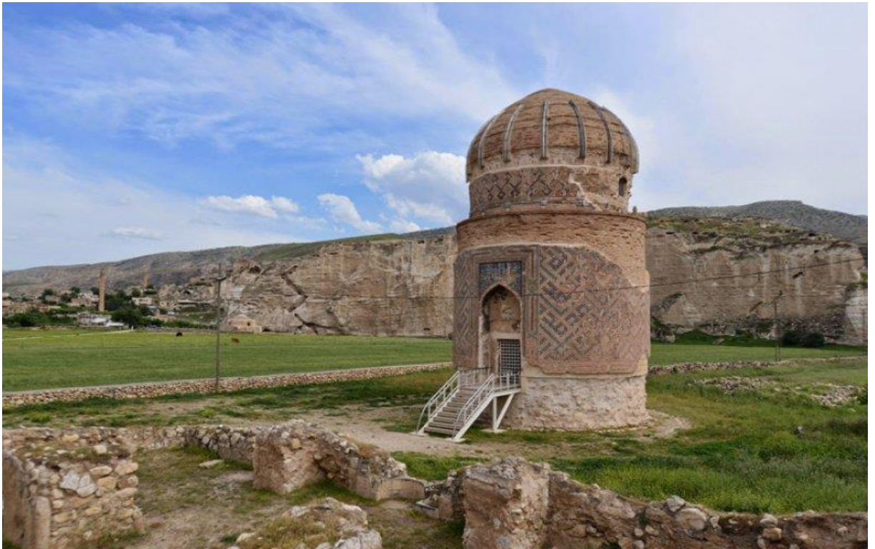
Şekil 3. 1. Zeynel Türbesi Genel Görüntüsü.
