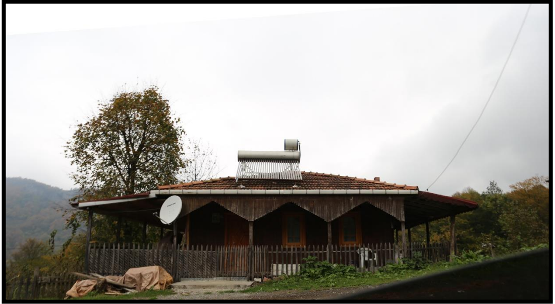
Şekil 31: Karacaören mahallesinden ahşap bir ev örneği (29 Ekim 2014).
