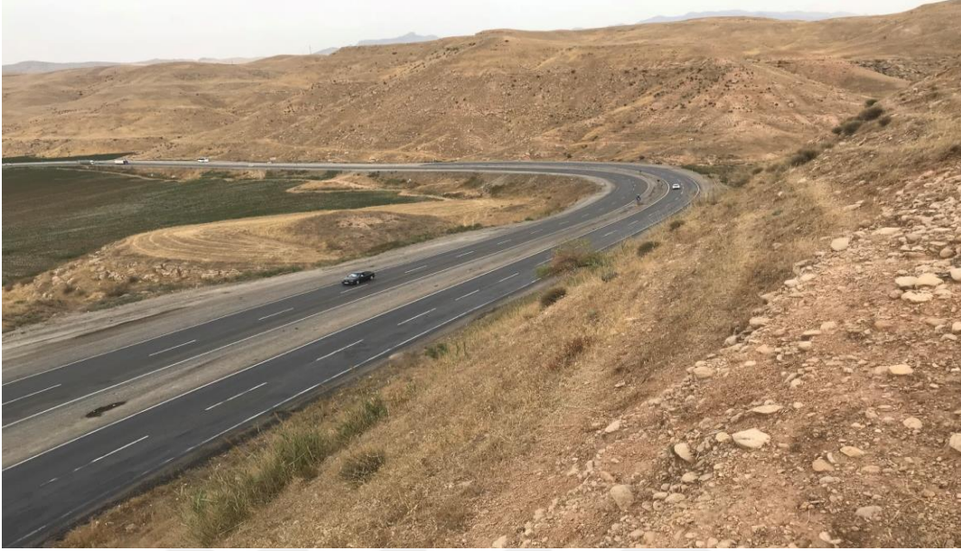
Şekil 4.101.430 Devlet Yolunu 01. Kontrol kesiminin 3±500 kilometresi
