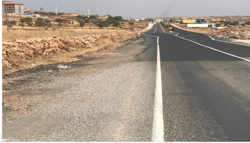
Şekil 4.91. 380 Devlet Yolunu 3. Kontrol kesiminin 10±500 kilometresi
