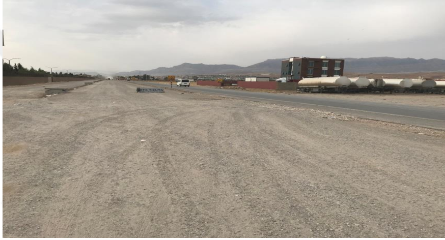
Şekil 4.99.430 Devlet Yolunu 01. Kontrol kesiminin 33±500 kilometresi
