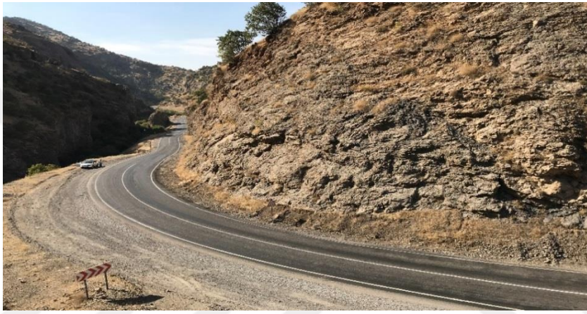
Şekil 4.97. 400 Devlet Yolunu 33. Kontrol kesiminin 16±500 kilometresi
