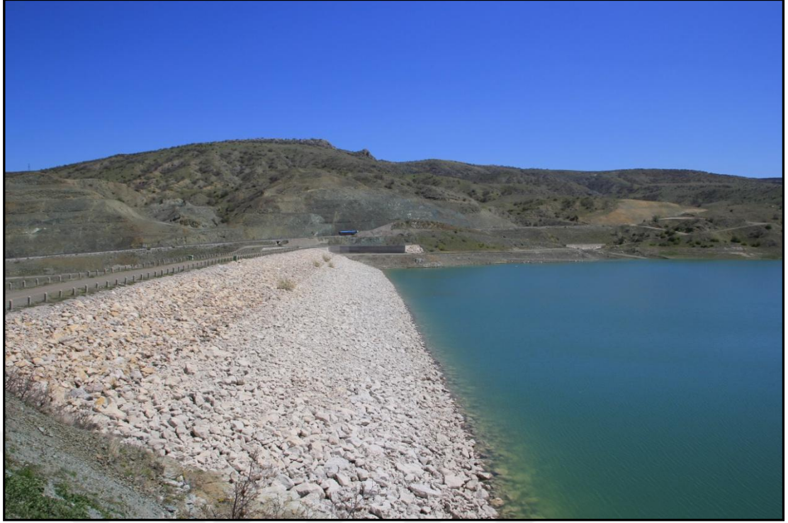
Şekil 40: Hatap Çayı üzerinde kurulmuş Hatap Barajı.
