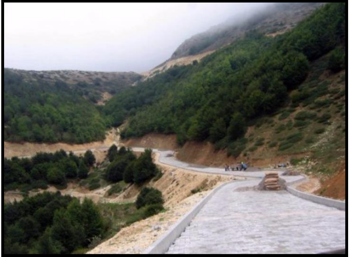
Foto 45: Ladik Yaylası Yol Çalışmalarından Görünüm, 2015
