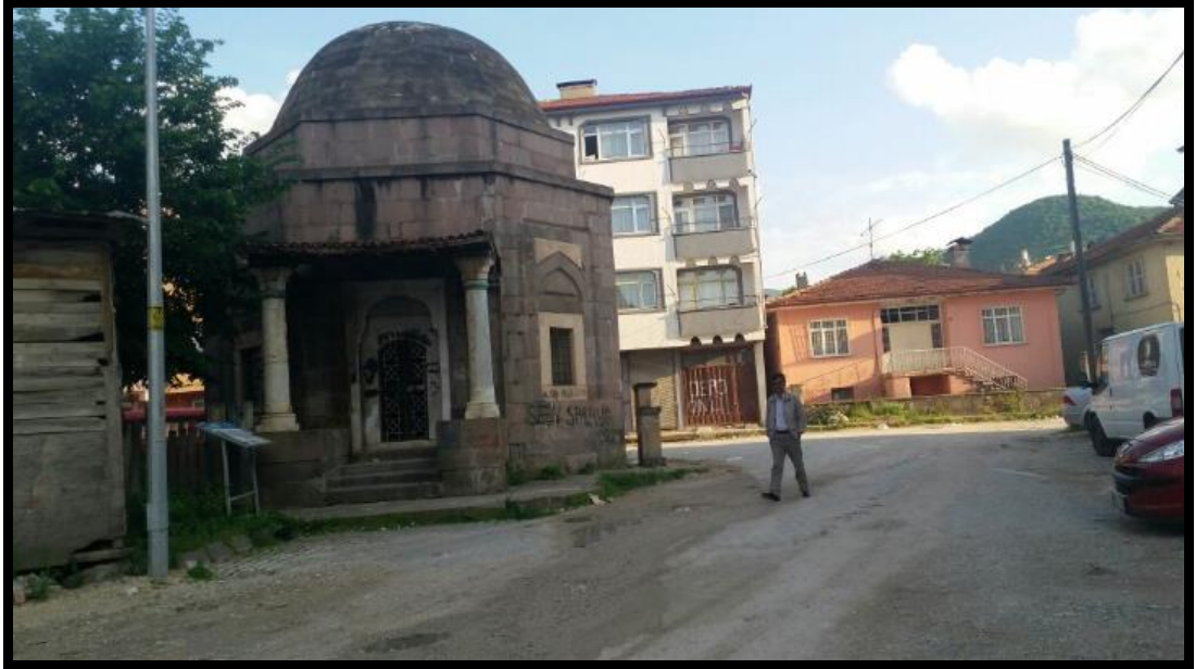
Foto 43: Sunullah Paşa Türbesi Koruma Sorunu Örneği (1), 2016
