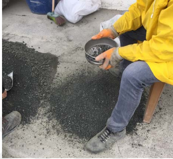
Şekil 3.19. Beton üretimi için numune eleme işlemleri
