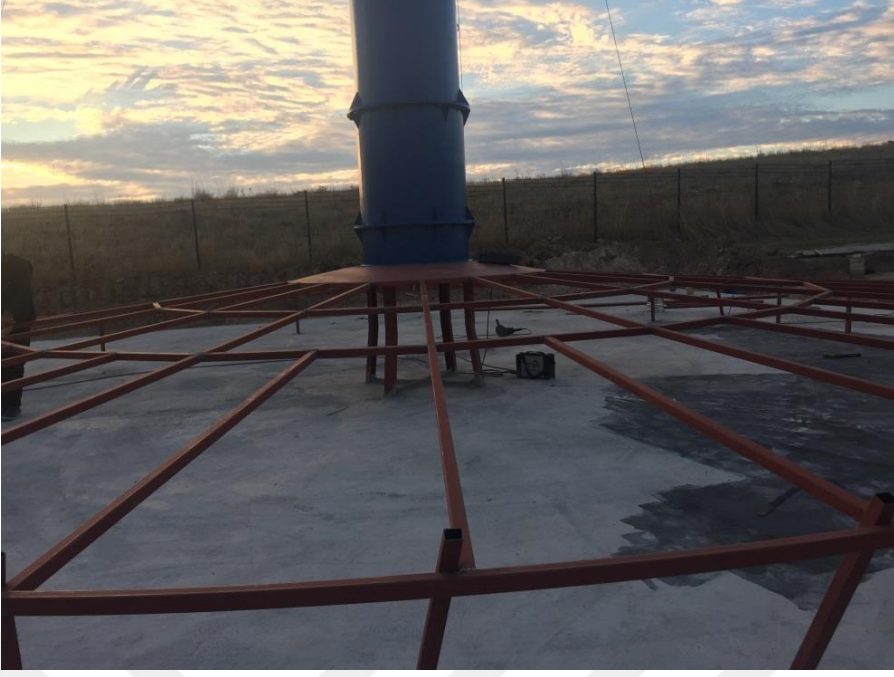
Şekil 3.8. Kolektörün bacaya montajı
