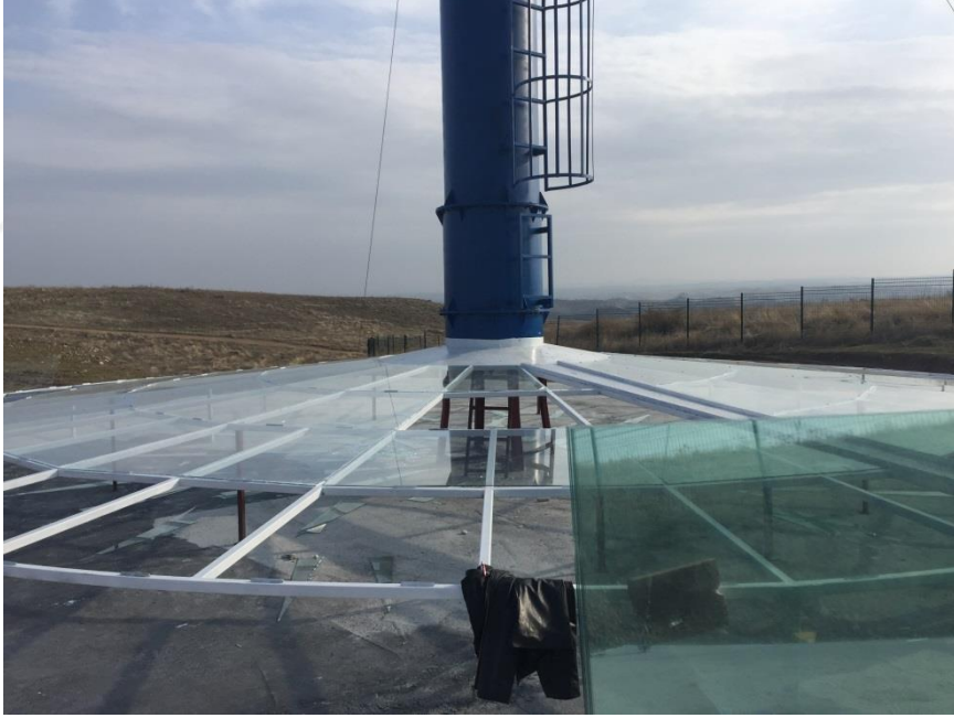
Şekil 3.9. Kolektör cam örtü malzemesinin yerleştirilmesi
