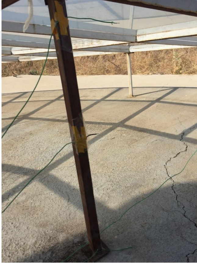
Şekil 3.17. Kolektör giriş ağzından bacaya doğru 3 metre ileri mesafede sıcaklık ölçümleri
