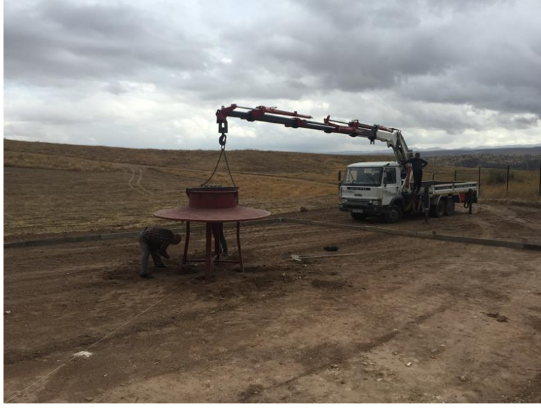
Şekil 3.4. Baca tabanının zemine kurulumu
