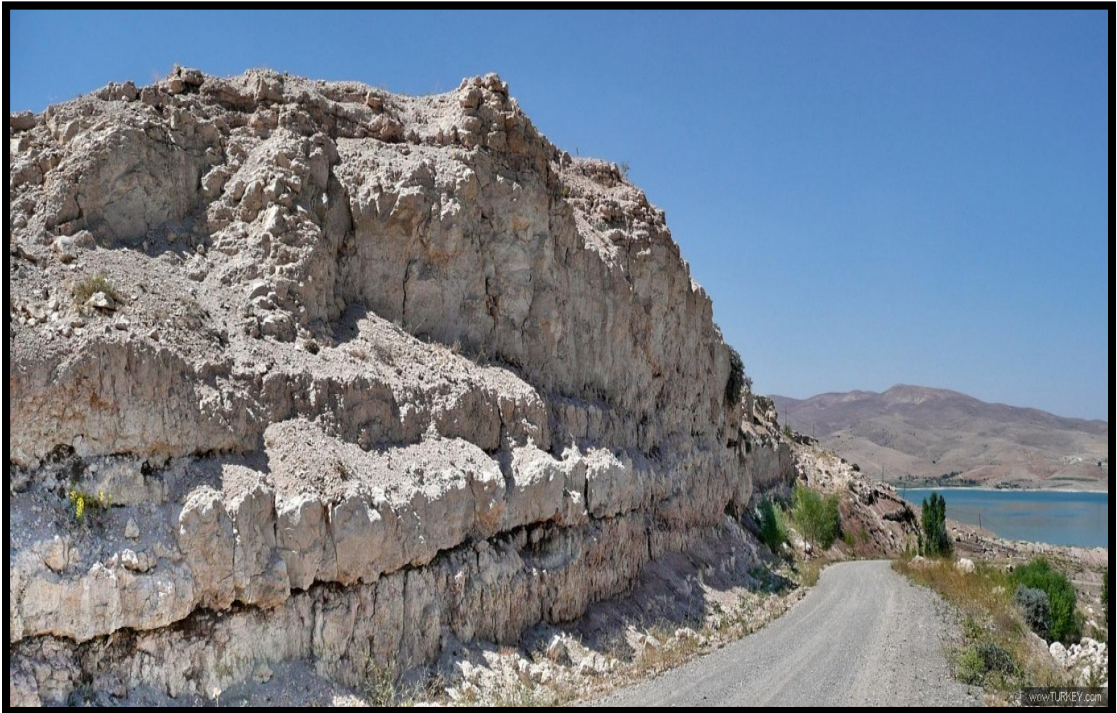
Şekil 36: Eski Taşhan köyü 1 numaralı heyelan sahası Kaynak: M, BUDAK 'tan alınmıştır.
