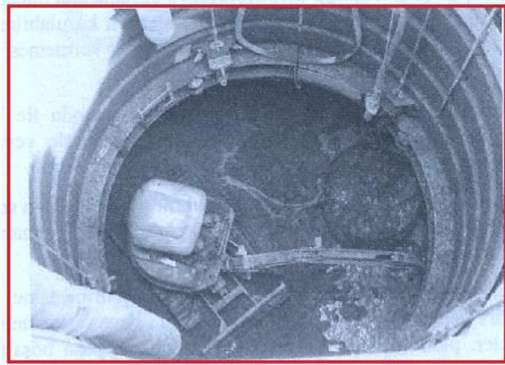
Şekil 3.3. Kuyuda yükleme için kullanılan mini beko (Köse ve ark.,1992)
