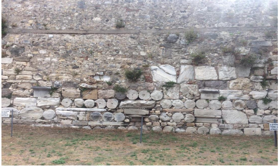
Fotoğraf 41. Sinop İçkale Surlarında Kullanılan Malzemeler.
