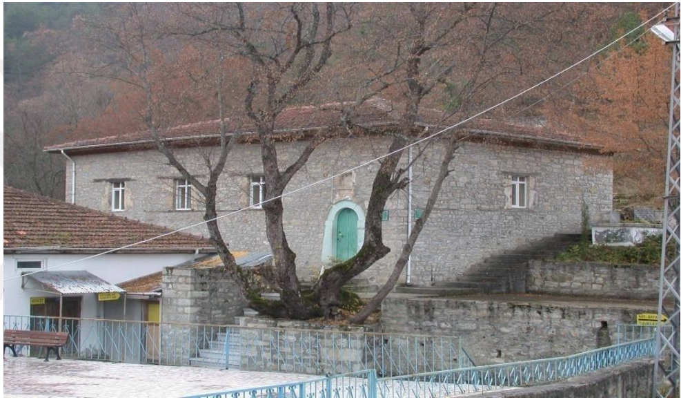
Fotoğraf 33. Sinop Çeçe Sultan Türbesi Dış Görünüm. 657
