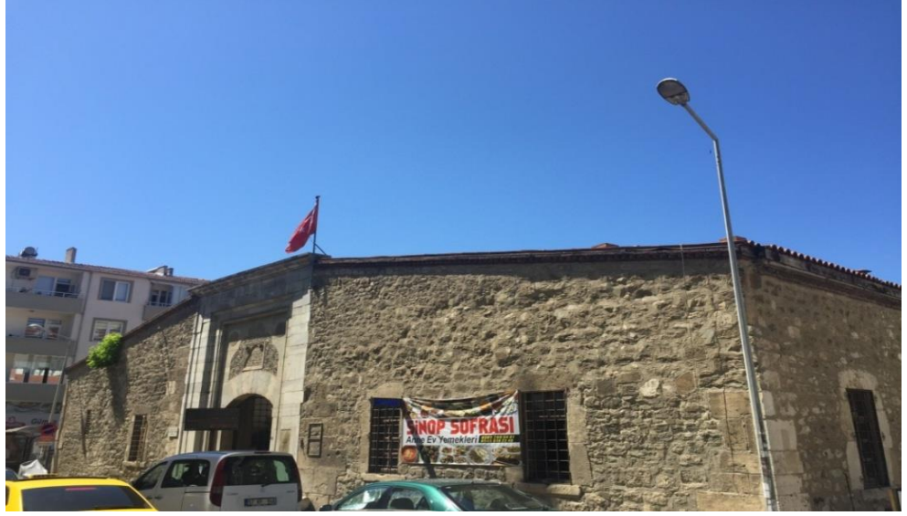
Fotoğraf 38. Sinop Pervane Medresesi Dış Görünüm.
