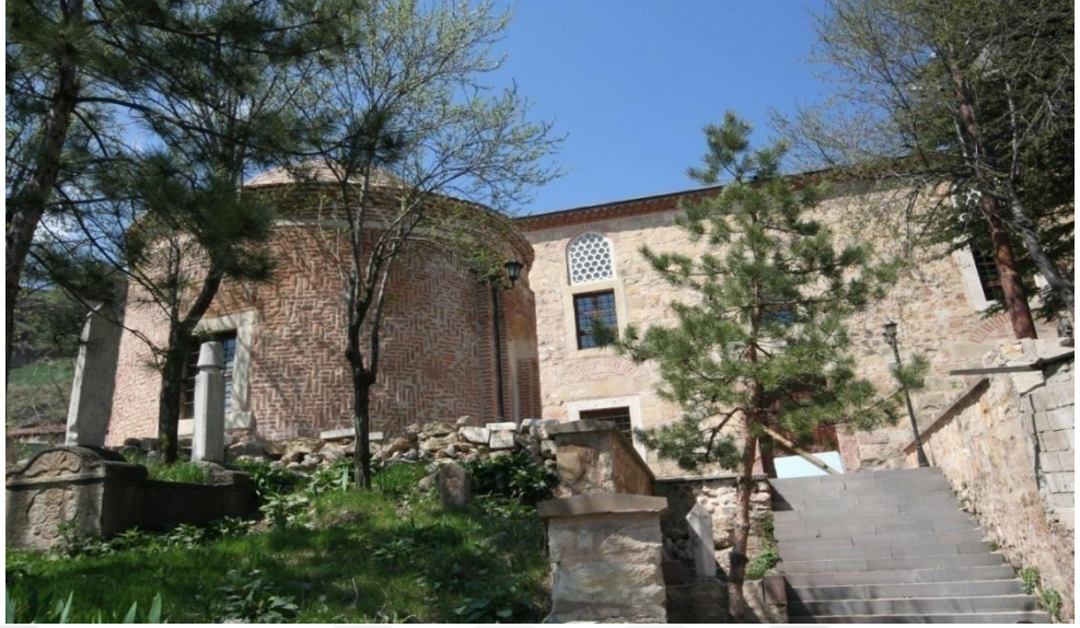
Fotoğraf 19. Kastamonu Atabey Gazi Camii Arka Cephe Görünüm. 615
