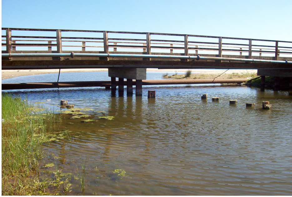
Şekil 3.3. Köprü ayağından bir görünüm(orijinal)
