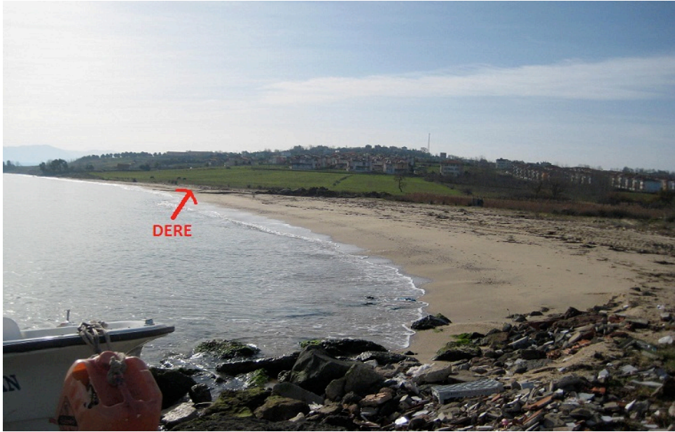
Şekil 13. DSİ-Kiraztepe (D) istasyonunda kaya bloklarının dalga etkisiyle ortaya çıkması sonucu yaklaşık 500 m güneybatıya kaydırılan istasyona ait görüntü (orijinal)
