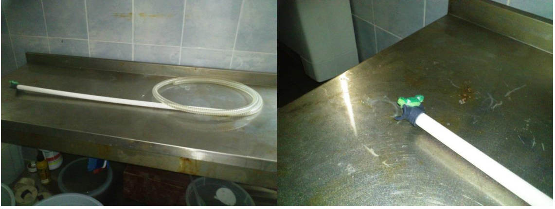
Şekil 4.8. Tank tabanının sifonlanmasında kullanılan boru sistemi (Orijinal)
