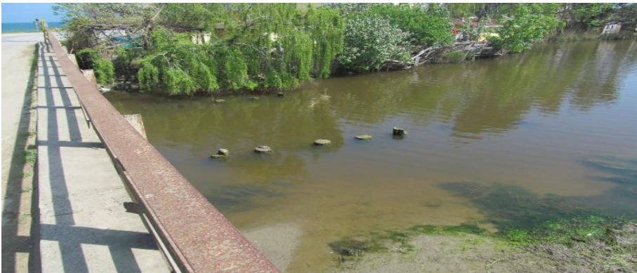
Şekil 3.3.6. Sırakaraağaçlar Deresi Yalınca Köprüsü Genel Görünümü
