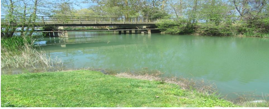
Şekil 3.3.1. Karasu Çayı-Yalnızca Köprüsü Genel Görünümü
