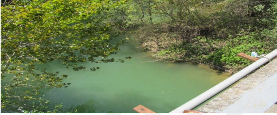
Şekil 3.3.3. Karasu Çayı-Karasu Köprüsü Genel Görünümü
