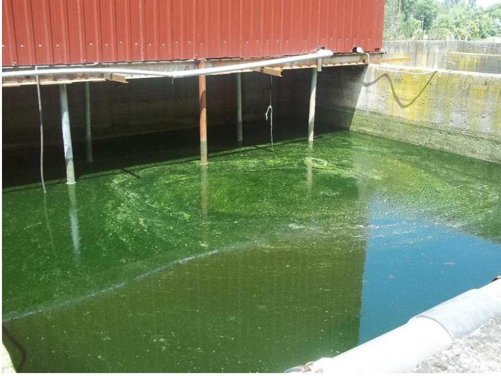
Şekil 5.1.3.12. Üzeri açık ve içi kirli su ile dolu ve içine düşenin çıkabileceği bir tertibat olmayan kirli su arıtma havuzu (Orijinal)
