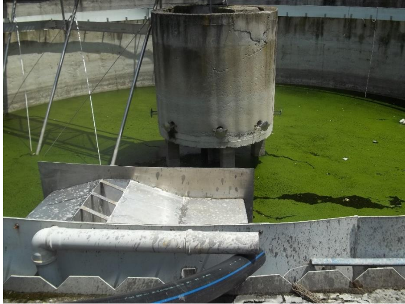
Şekil 5.1.3.11. Üzeri açık ve içi kirli su ile dolu ve içine düşenin çıkabileceği bir tertibat olmayan eski ağ yıkama havuzu (Orijinal)
