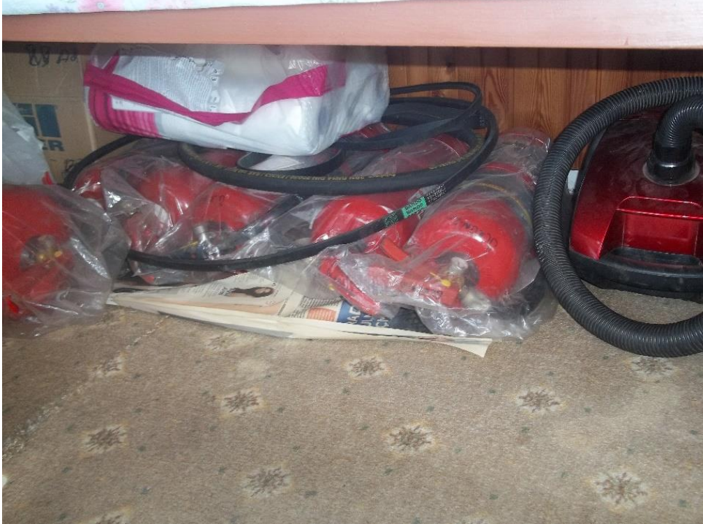
Şekil 5.1.2.3. Tamamı kaptan köşkünde toplanmış, ulaşımı zor ve üzerindeki muşamba sebebi ile kullanıma sokulması gecikebilecek yangın tüpleri (Orijinal)
